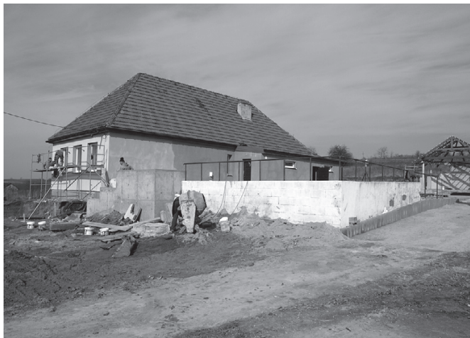
Roboty przy budynku świetlicy w Siedliskach. Fot. R. Stojek
