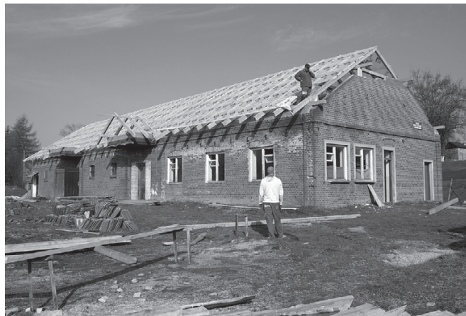
Roboty przy budynku świetlicy w Książnicach Małych. Fot. R. Stojek
