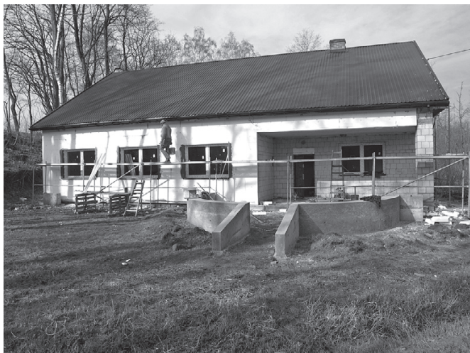
Roboty przy budynku świetlicy w Jankowicach. Fot. R. Stojek
