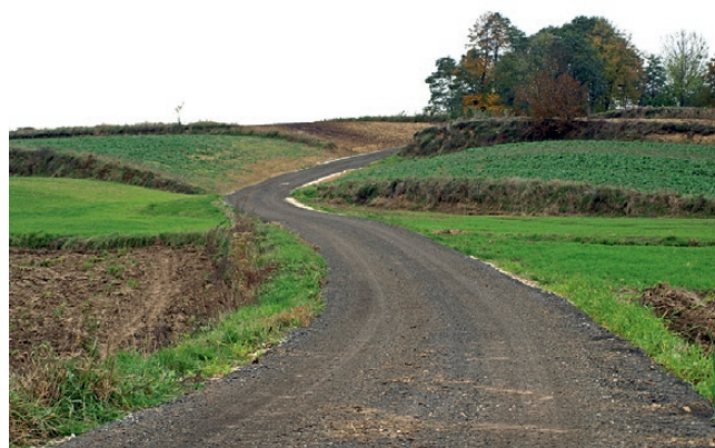
Droga gminna Modrzany – Majkowice (nawierzchnia z destruktu asfaltowego)
