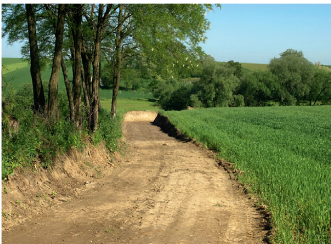
Jankowice, droga gruntowa wykonana z funduszu sołeckiego
