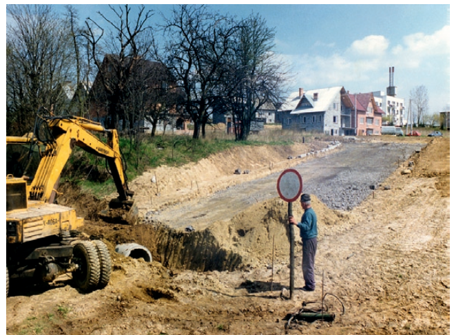
Budowa szkoły w Koszyckach, 1995 r.
