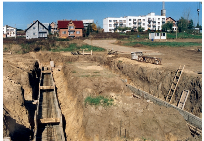
Budowa szkoły w Koszyckach, wrzesień 1995 r.
