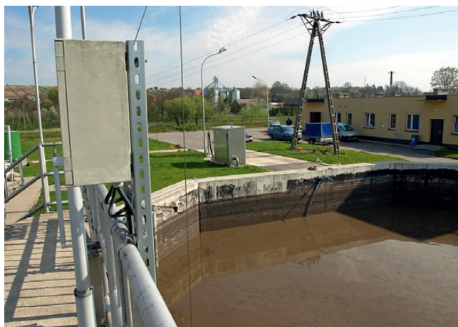
Oczyszczalni ścieków we Włostowicach, rok 2014
