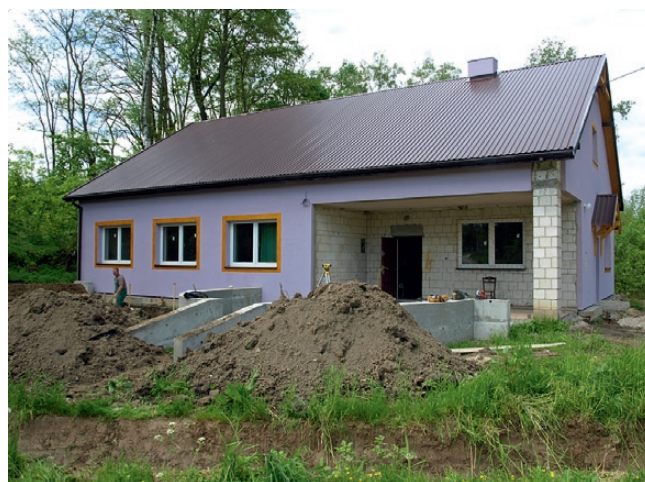
Dobiegają końca prace przy świetlicy wiejskiej w Jankowicach
