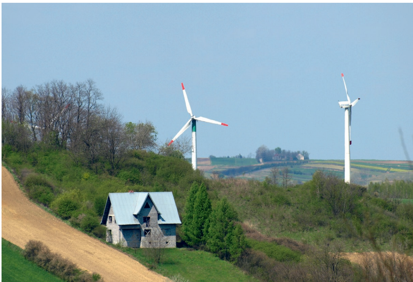
Elektrownia wiatrowa na Podgaju
