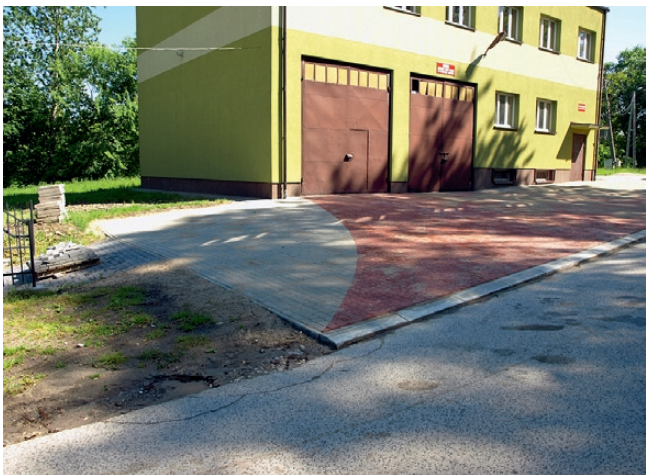
Książnice Wielkie, plac manewrowy przed remizą wykonany z funduszu sołeckiego
