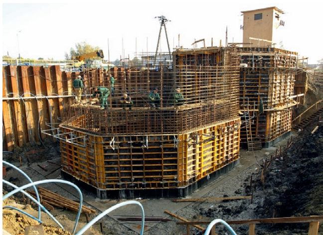
Modernizacja oczyszczalni ścieków we Włostowicach, rok 2009
