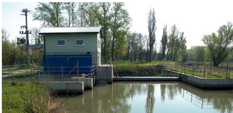
Elektrownia wodna na rzece Szreniawie we Włostowicach
