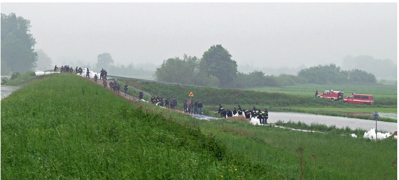
Siedliska, powódź 2010, strażacy ratują przeciekający wał
