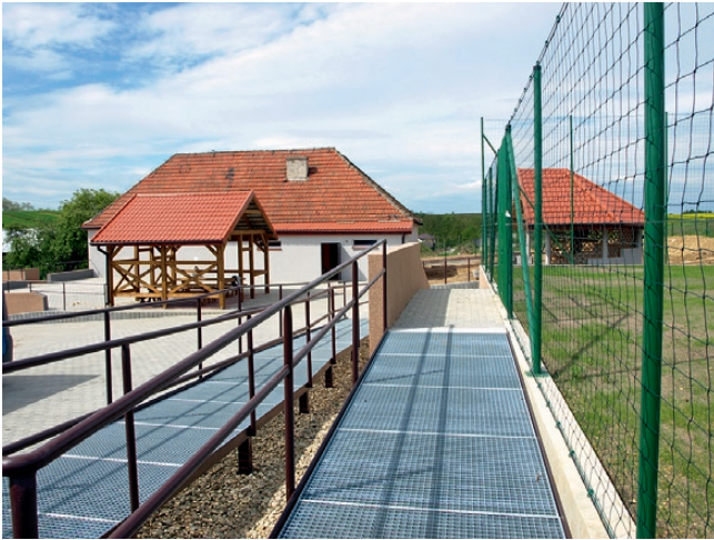
Dobiegają końca prace przy zagospodarowaniu terenu świetlicy wiejskiej w Siedliskach
