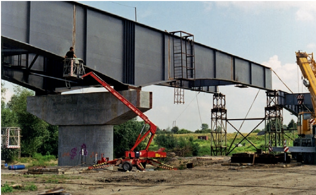
Budowa mostu na Wiśle
