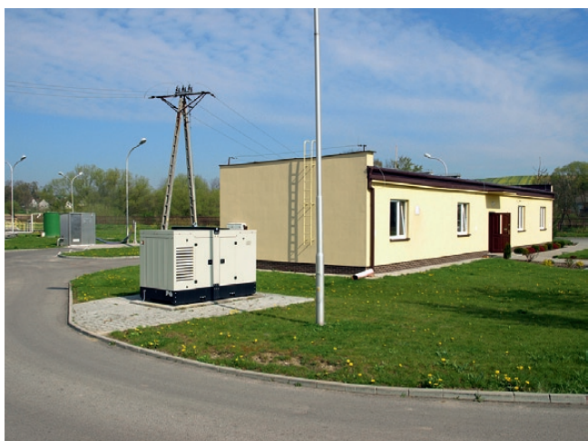
Oczyszczalni ścieków we Włostowicach, rok 2014
