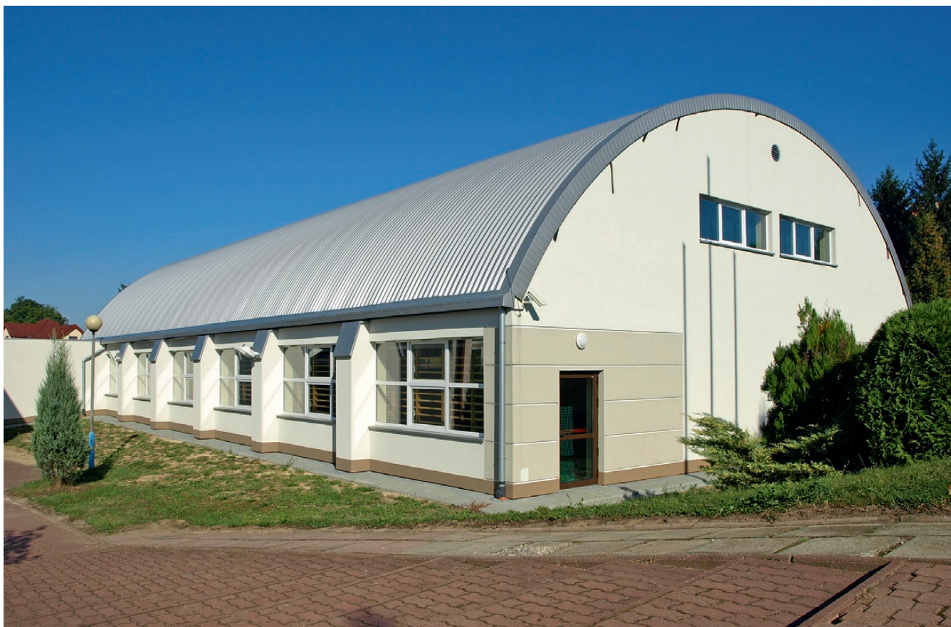
Nowa hala sportowa przy Centrum Oświatowym w Koszycach
