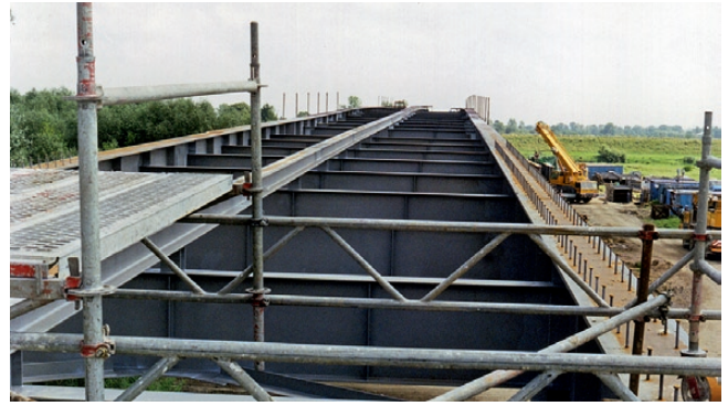
Budowa mostu na Wiśle
