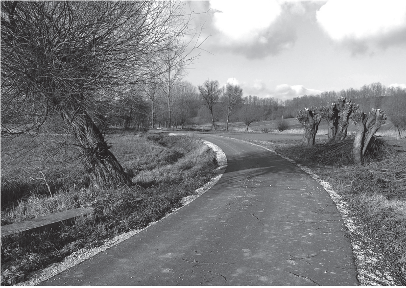
Zmodernizowana droga w Malkowicach – Siedliskach. Fot. R. Stojek
