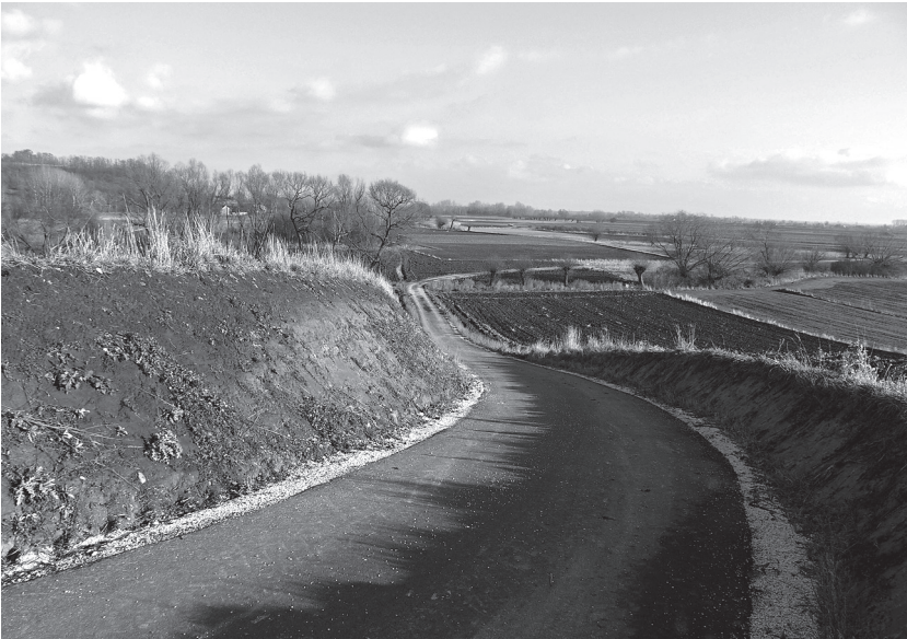
Zmodernizowana droga w Sokołowicach. Fot. R. Stojek
