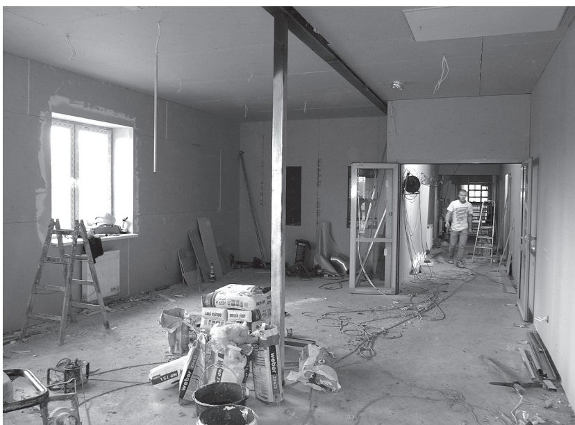
Trwają prace wykończeniowe przy budynku dziennego domu pobytu „Senior-WIGOR” w Książnicach Małych. Fot. R. Stojek
