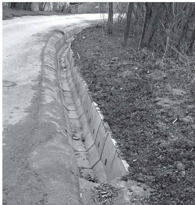
Budowa korytek przy drodze gminnej w miejscowości Witów
