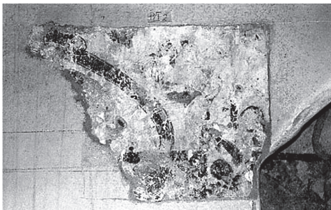
Witów, kościół parafialny, prezbiterium, odkrywka po lewej stronie włączy na sedilla. Odslonięty fragment przedstawia skrzydło anioła dotykające linii oddzielającej sferę niebiańską od piekielnej
