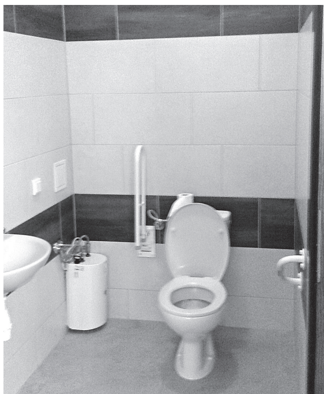
Wykonanie łazienki w remizie w Książnicach Wielkich
