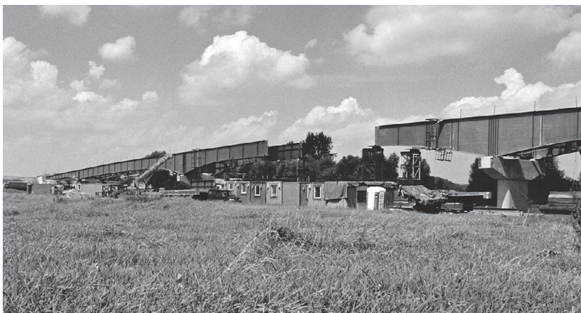
Budowa mostu. Fot. R. Stojek
