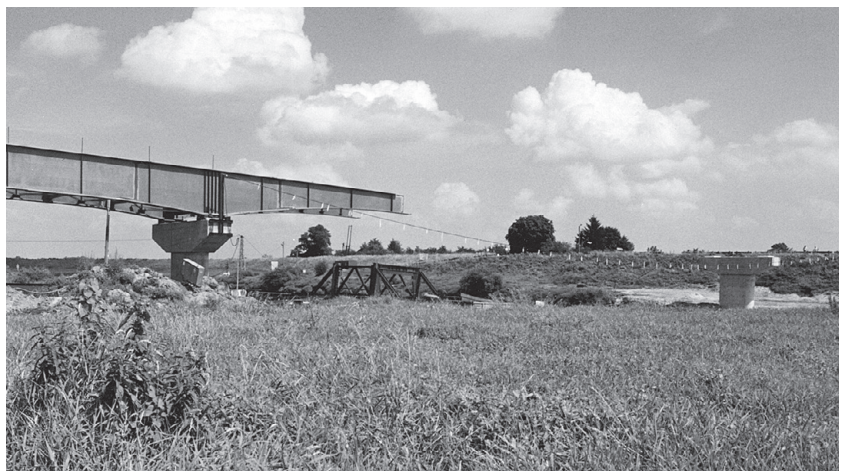
Budowa mostu. Fot. R. Stojek
