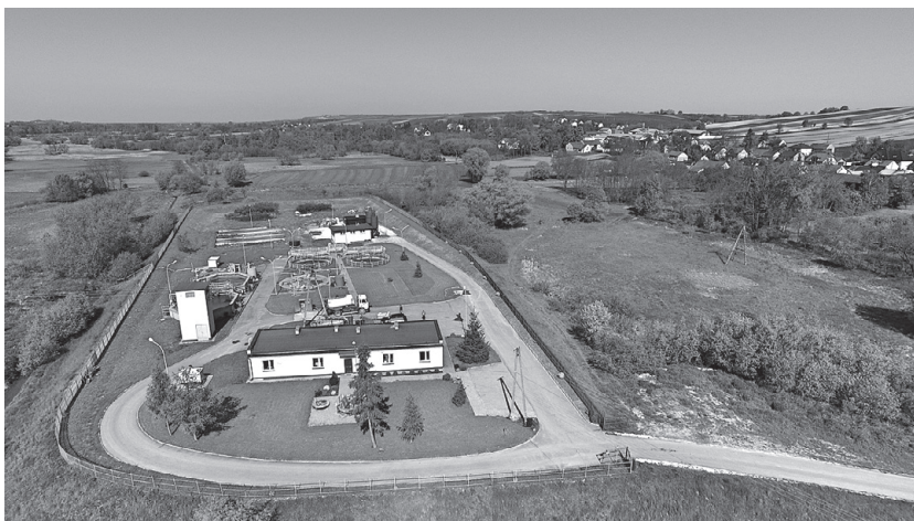
Oczyszczalnia ścieków we Włostowicach – siedziba Przedsiębiorstwa
