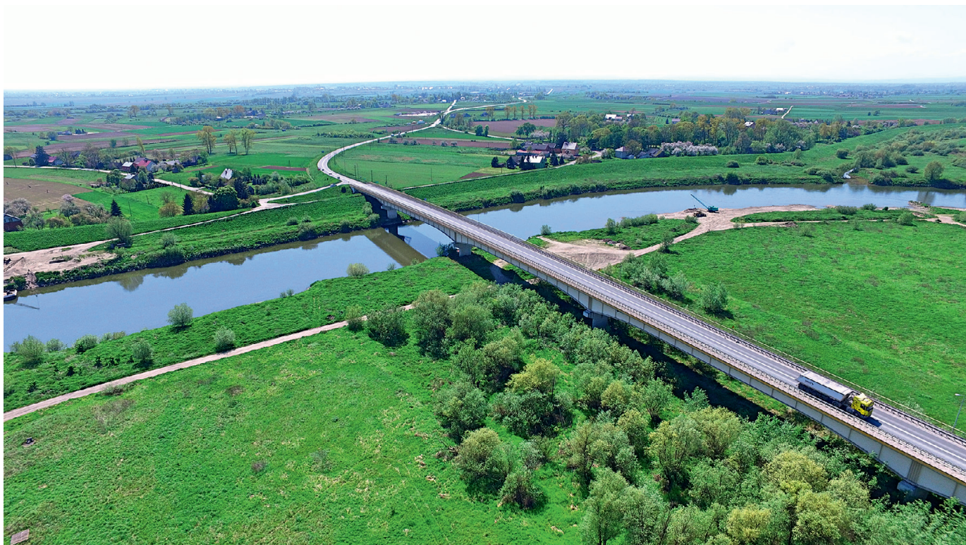
Most na Wiśle w Sokołowicach
