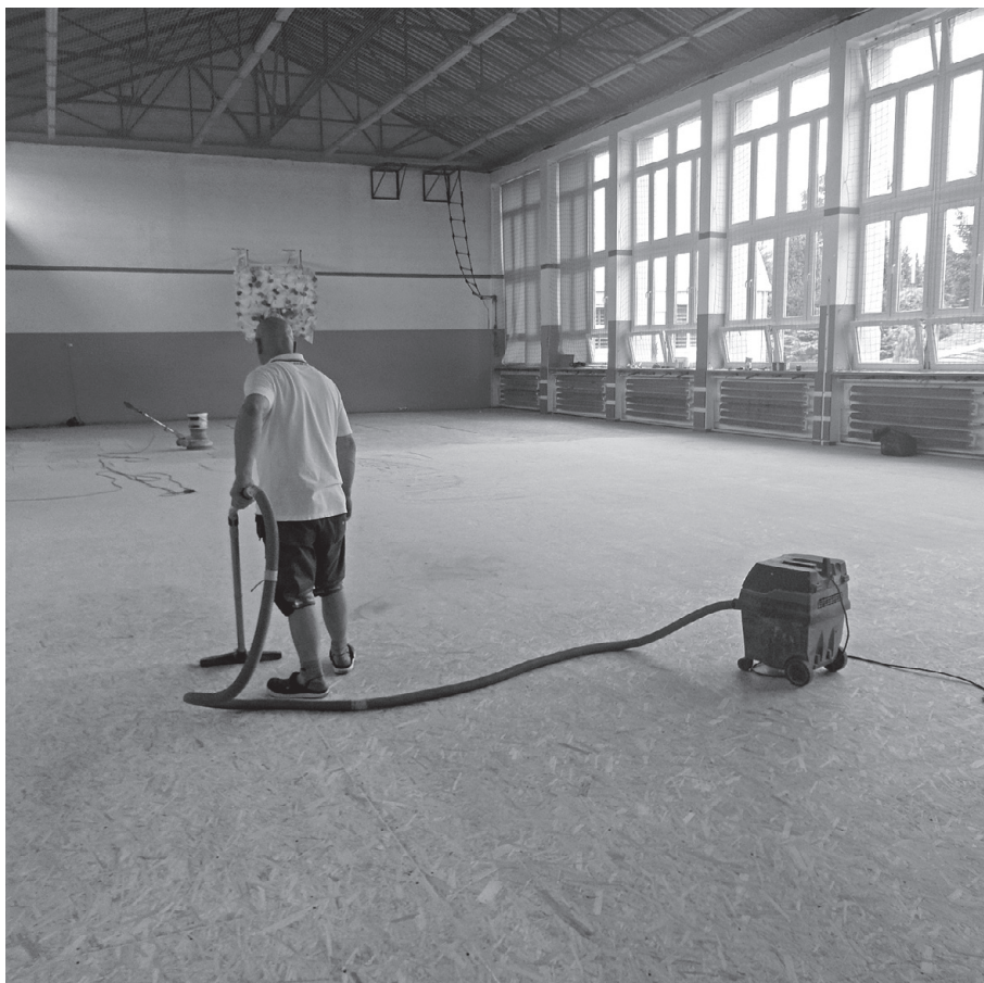
Remont sali gimnastycznej w Koszycach
