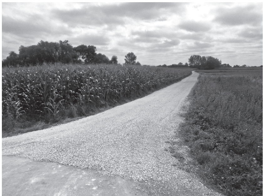
Remont drogi dojazdowej do wału w miejscowości Morsko
