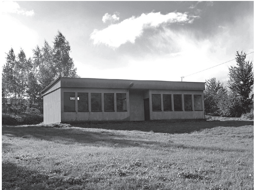
Docieplenie budynku świetlicy wiejskiej w Filipowicach
