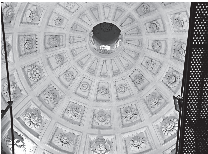
Wnętrze kopuły kaplicy z latarnią
