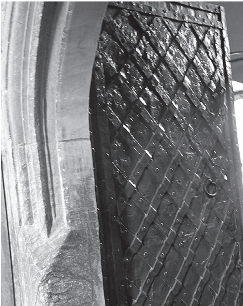
Żelazne drzwi do zakrystii)
