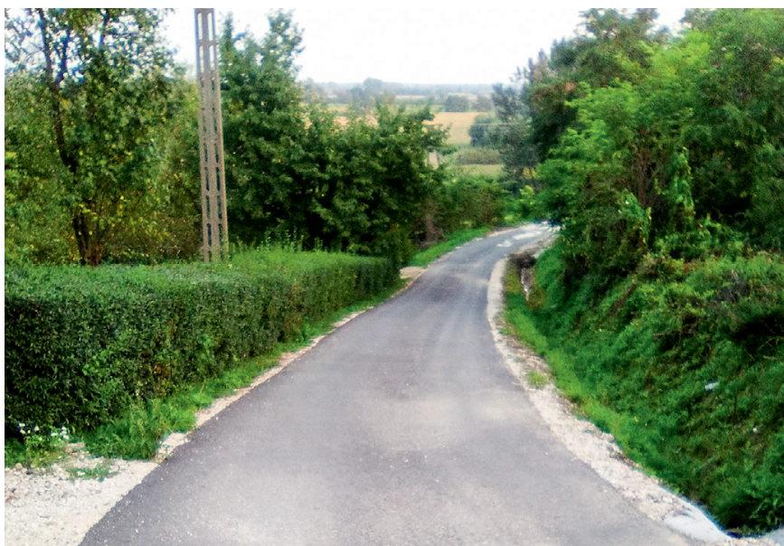
Remont drogi dojazdowej w sołectwie Morsko
