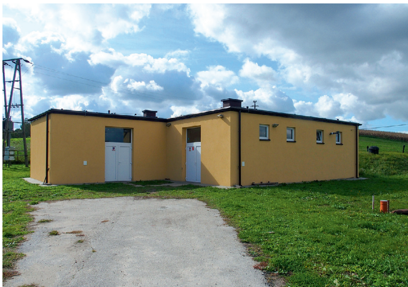
Stacja uzdatniania wody w Witowie
