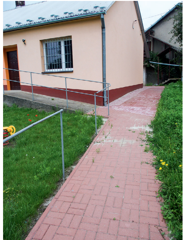
Wyremontowana świetlica wiejska w Modrzanach
