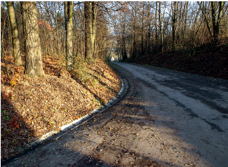
Korytka ściekowe przy drodze gminnej w sołectwie Witów
