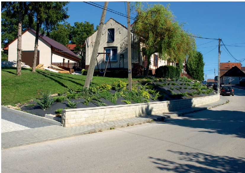
Zmodernizowana ul. Wesoła
