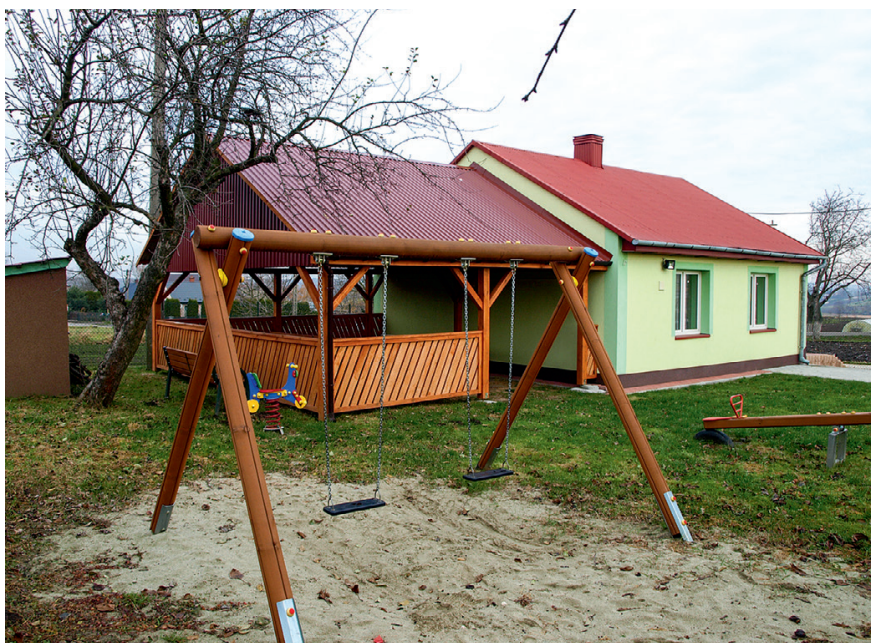
Zagospodarowanie placu przy świetlicy wiejskiej w Zagaju
