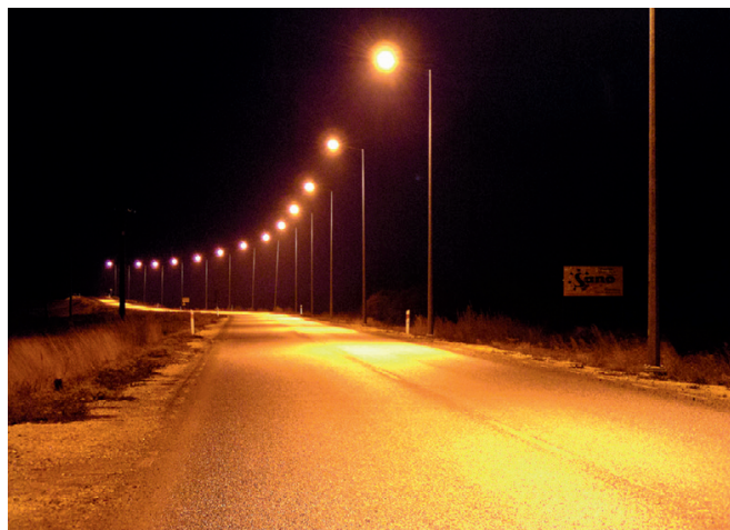
Oświetlenie dojazdu do mostu na Wiśle
