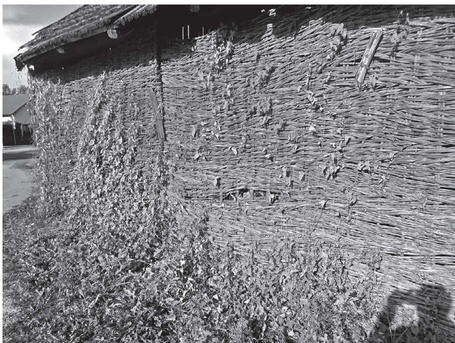
Stodoła z wiklinowymi ścianami przy ulicy Mazowieckiej w Koszycach
