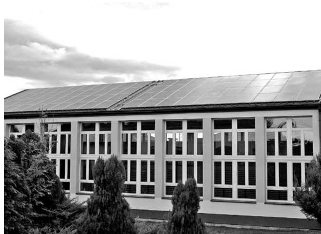
Fotowoltaika na budynku szkoły w Koszycach
