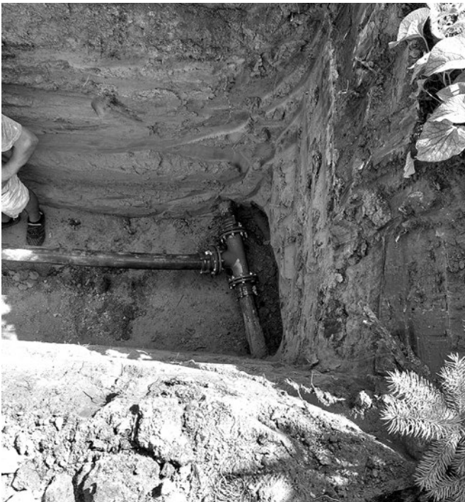
Trójnik na sieci wodociągowej wykonywanej metodą przewiertu sterowanego
