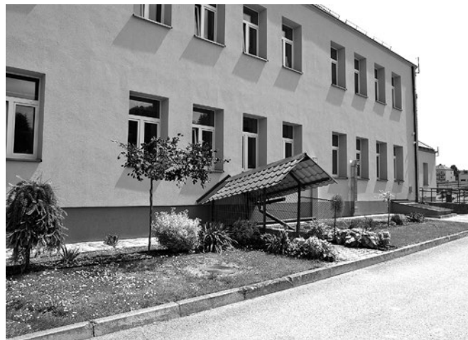
Ocieplenie budynku szkoły w Książnicach Wielkich
