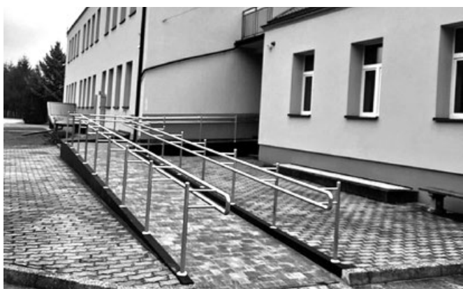
Odnowiony podjazd dla osób niepełnosprawnych przy szkole w Książnicach Wielkich
