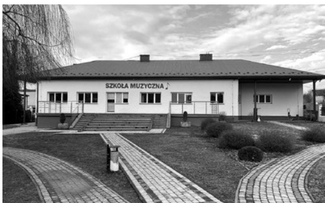
Odnowiona elewacja wraz z tarasem - szkoła muzyczna
