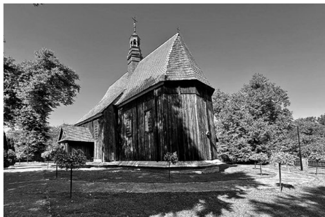
Kościół pw. Narodzenia NMP w Rachwałowicach po remoncie
