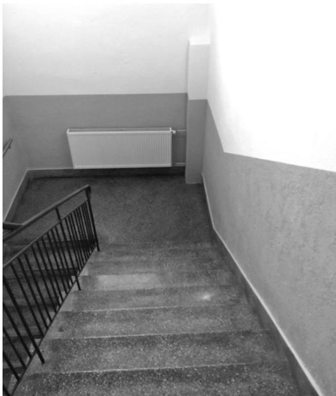
Odnowiona klatka schodowa w remizie OSP w Rachwałowicach
