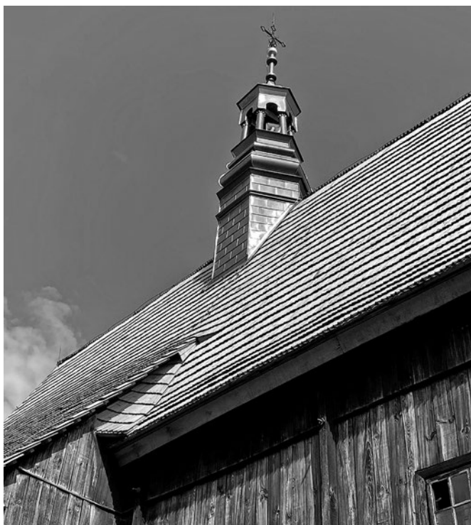
Wyremontowana sygnaturka kościoła
