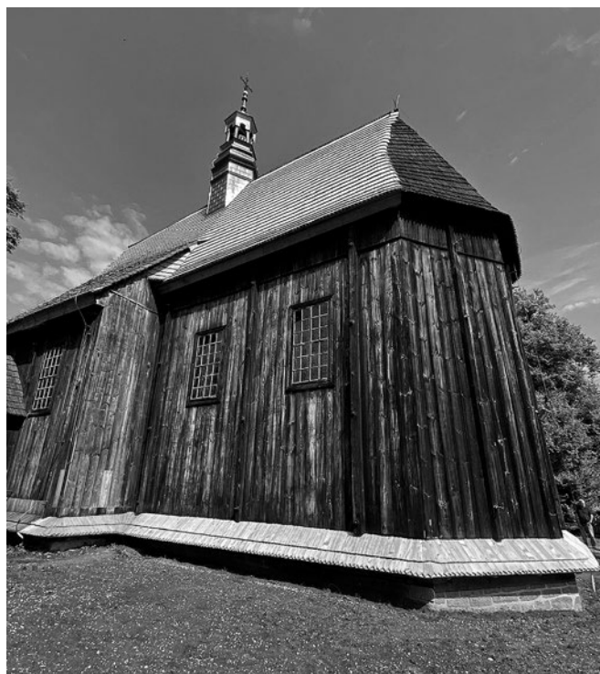
Część kościoła z nowymi fundamentami i fartuchem zabezpieczającym
