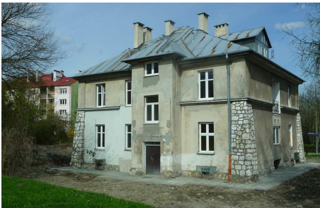
Fot. nr 133 (133-136). W podgórskiej części dawnego KL Płaszów. „Szary Dom” przy ulicy Jerozolimskiej 3 został zbudowany w roku 1925. Pierwotnie pełnił funkcję budynku administracyjnego cmentarza Gminy Wyznaniowej Żydowskiej w Krakowie i siedziby Bractwa Przedpogrzebowego Chewra Kadisza. W czasie funkcjonowania KL Płaszów mieściły się w nim biura zarządu obozu, a w piwnicach areszt i katownia. (16.04.2023)
