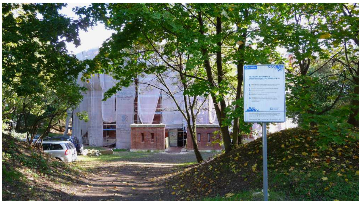
Fot. nr 277 (277-278). Wreszcie trwa kompleksowy remont fortu. (21.10.2024)
