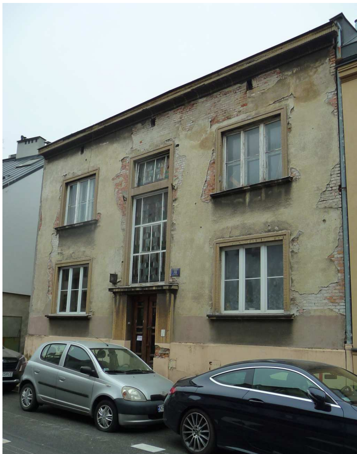
Fot. nr 96 (96-98). Zapewne międzywojenny dom pod nr 78. (25.05.2023)
