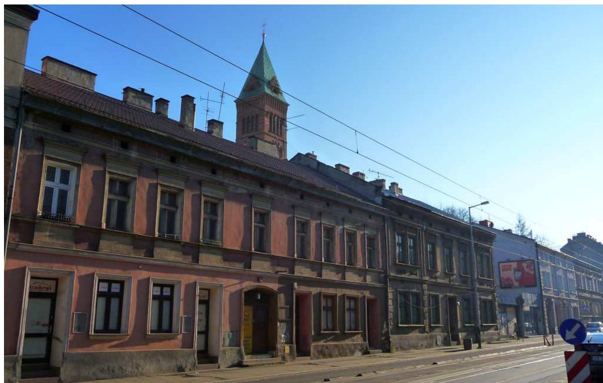
Fot. nr 361 (361-362). Fragment niskiej zabudowy ulicy Kalwaryjskiej, tu o nr: 45 -53. (01.12.2024)
