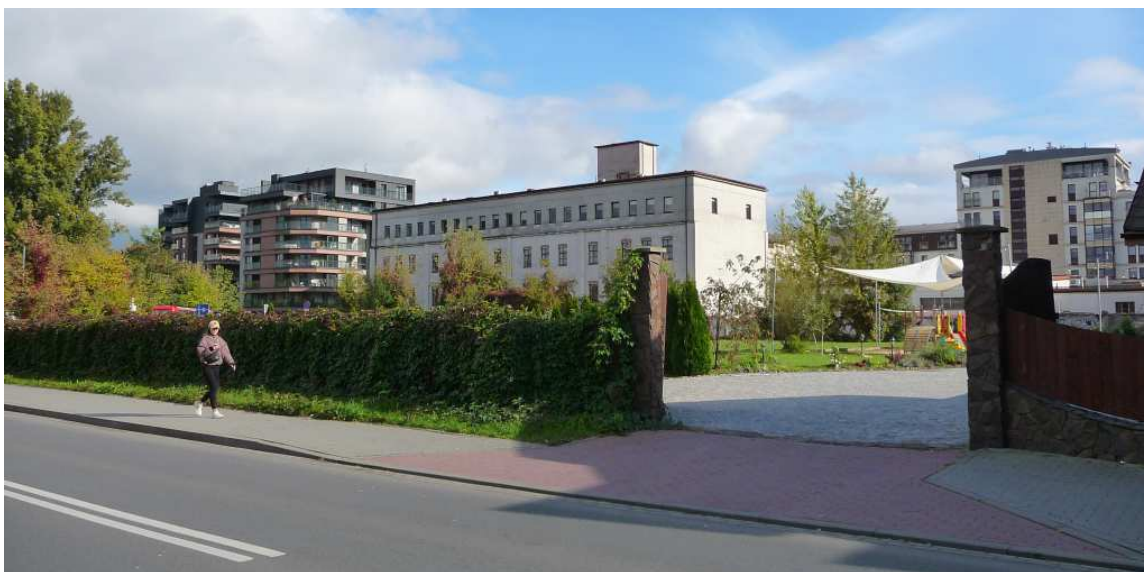
Fot. nr 330. Dawne zabudowania garbarni Progres w narożu ulic: Zabłocie 15 i Przemysłowej 2. Budynek fabryczny. (06.10.2024)
