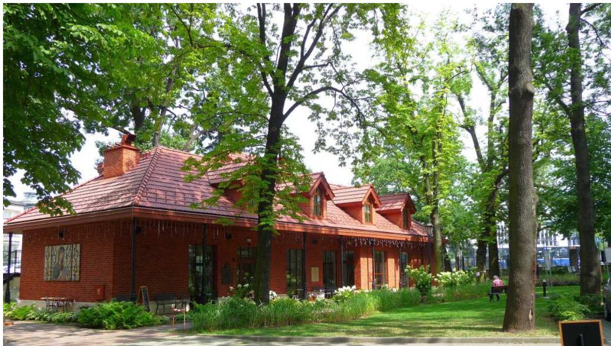
Fot. nr 272. Pijalnia zdrojowa uruchomiona w roku 2021. (08.07.2024)
