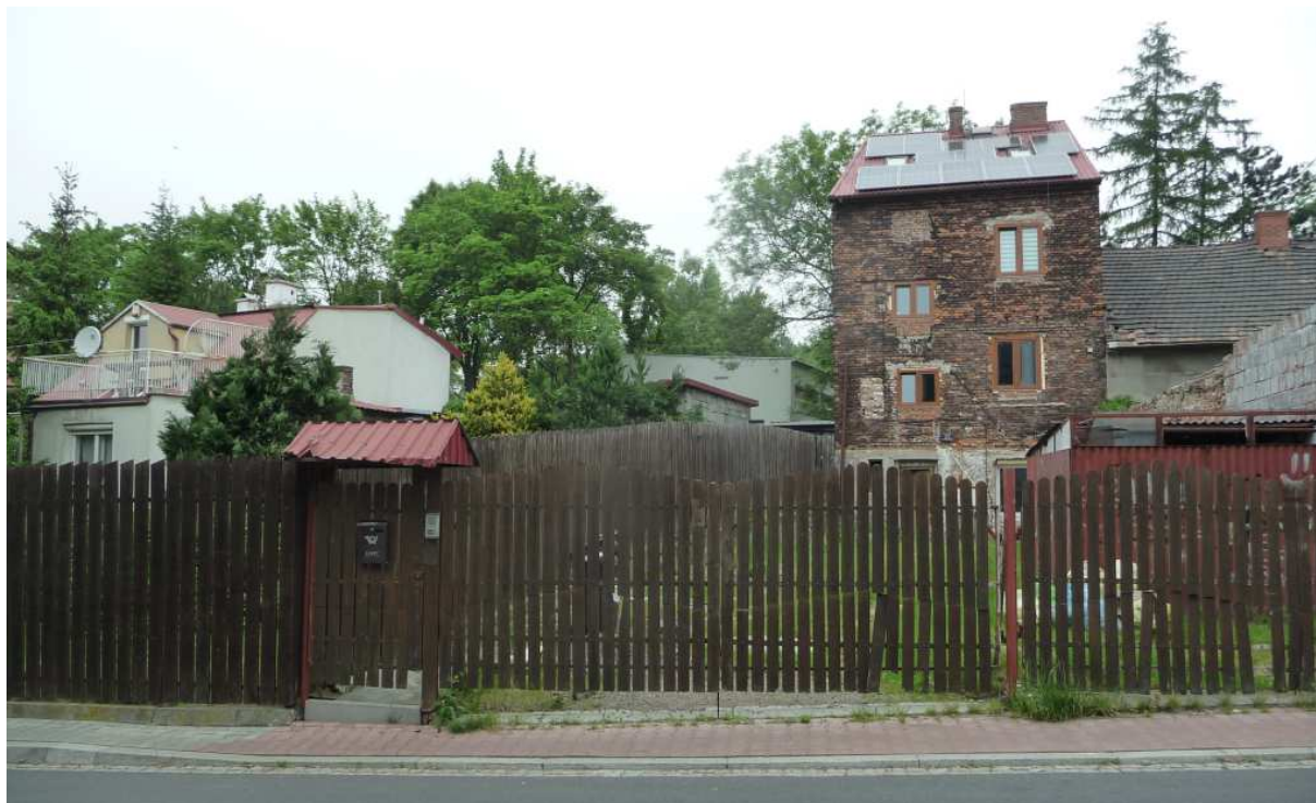
Fot. nr 100. Zapewne przedwojenny dom (w głębi) pod nr 33. (25.05.2023)
