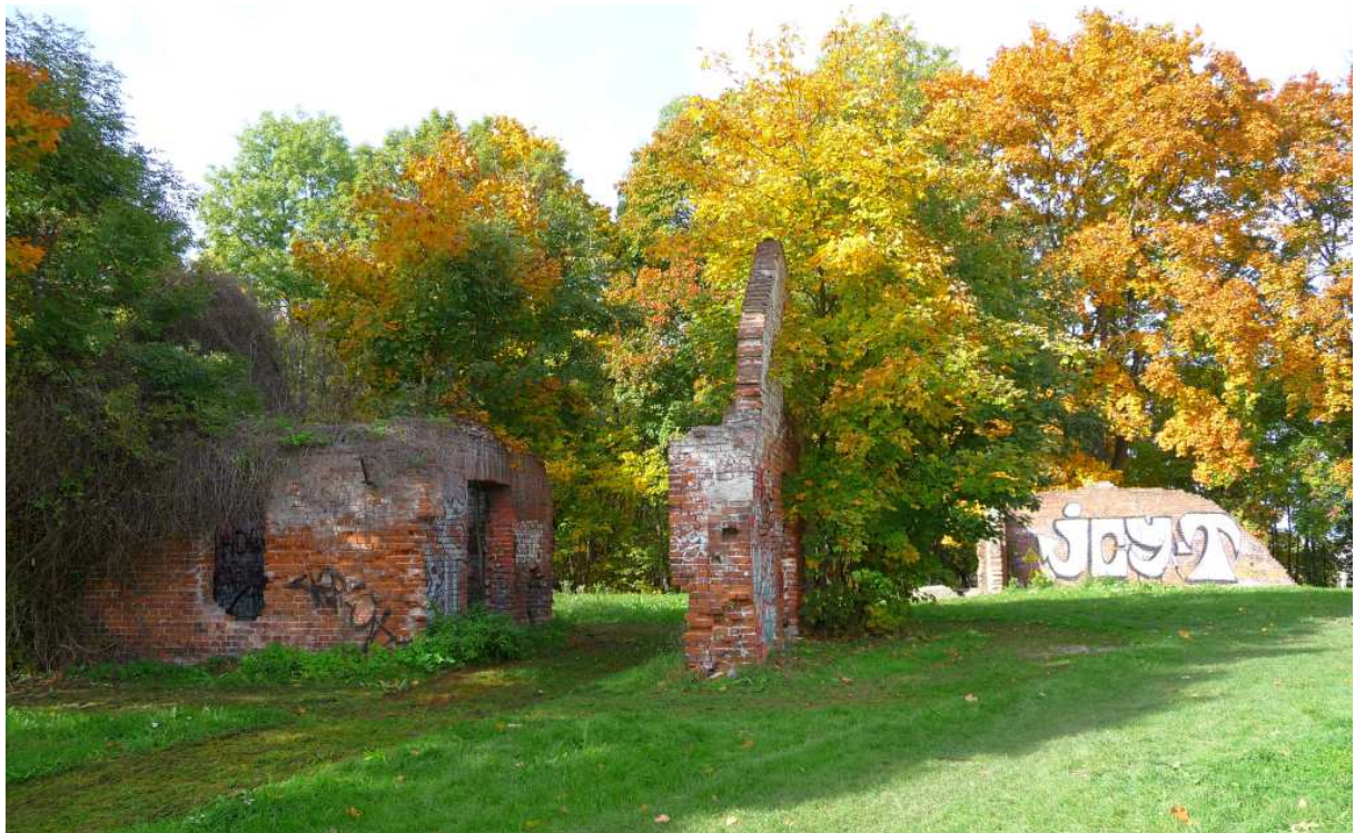
Fot. nr 494 (494-495). Przy ruinach dawnej prochowni z czasów Twierdzy Kraków przy ulicy Swoszowickiej. (13.10.2025)
