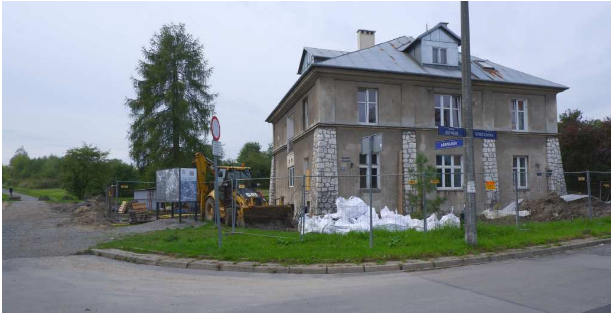
Fot. nr 18 (18-20). Remontowany, dawny budynek administracyjny przy nowym podgórskim kirkucie przy ulicy Jerozolimskiej 3, powstały w okresie międzywojennym, który w czasie istnienia KL Płaszów był siedzibą ss-manów i lokalną katownią. (24.09.2022)
