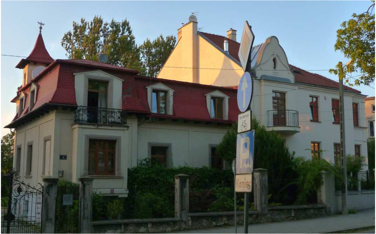
Fot. nr 435. Wille przy Placu Lasoty pod nr: 6 i 7. (10.08.2025)
