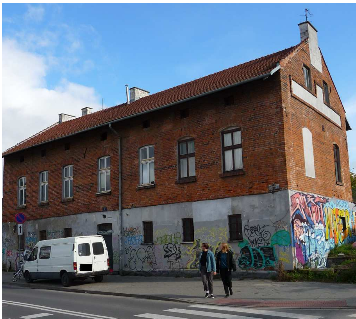
Fot. nr 327 (327-328). Budynek dawnego magazynu wojskowego pod nr 9a. (06.10.2024)
