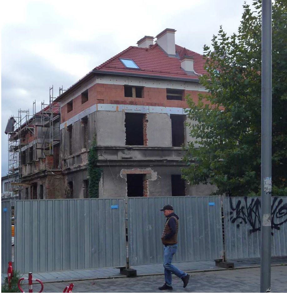
Fot. nr 334 (334-335). Dawna willa przy fabryce wyrobów metalowych Józefa Goreckiego pod nr 9, wybudowana w roku 1899 wg projektu Władysława Kleinbergera na etapie remontu. (06.10.2024)
