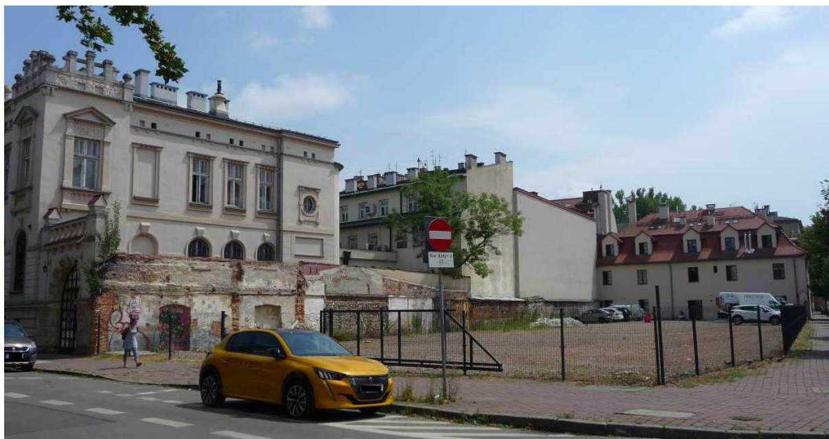
Fot. nr 262 (262-263). Pusta przestrzeń po wyburzeniu parterowych pomieszczeń w zespole dawnego zajazdu Pod Kotwicą, w narożu z ulicą Węgierską. (08.07.2024)
