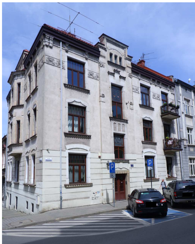
Fot. nr 203 (203-204). Secesyjna kamienica pod nr 7. (08.05.2024)
