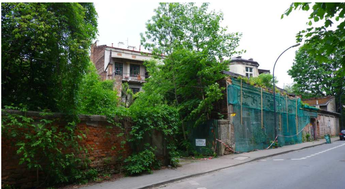
Fot. nr 216. Zapewne ostatnie chwile zabudowy o numerach: 55 i 57. (08.05.2024)
