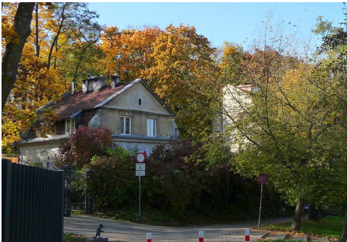
Fot. nr 285. Domek pod przy ulicy Parkowej 10, zapewne związany z obsługą Parku Bednarskiego, przy wejściu na jego teren, wybudowany ok. roku 1910. (21.10.2024)
