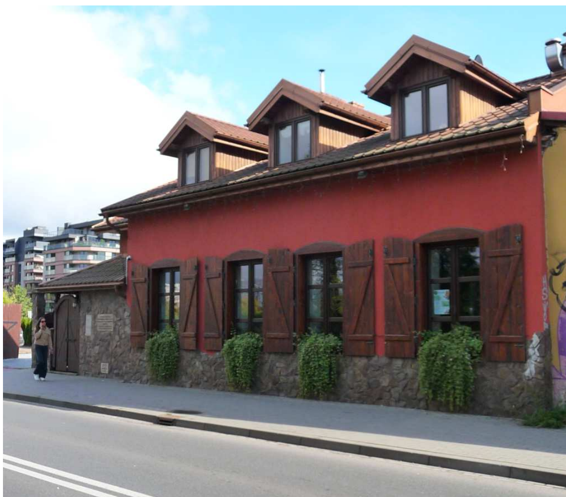
Fot. nr 329. Odnowiony, częściowo zrekonstruowany budynek w zespole dawnej rzeźalni pod nr 13, wybudowany w latach 80. XIX wieku. (06.10.2024)
