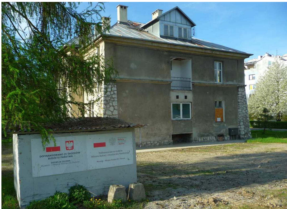
Fot. nr 250 (250-251). Szary Dom przy ulicy Jerozolimskiej przeznaczony na „Muzeum – Miejsce Pamięci KL Płaszów”. (07.04.2024)
