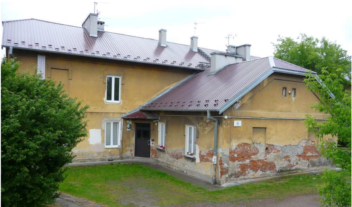
Fot. nr 424. Dom z ulicy Kiełkowskiego 16 przynależny do powyższej kolonii. (18.05.2025)
