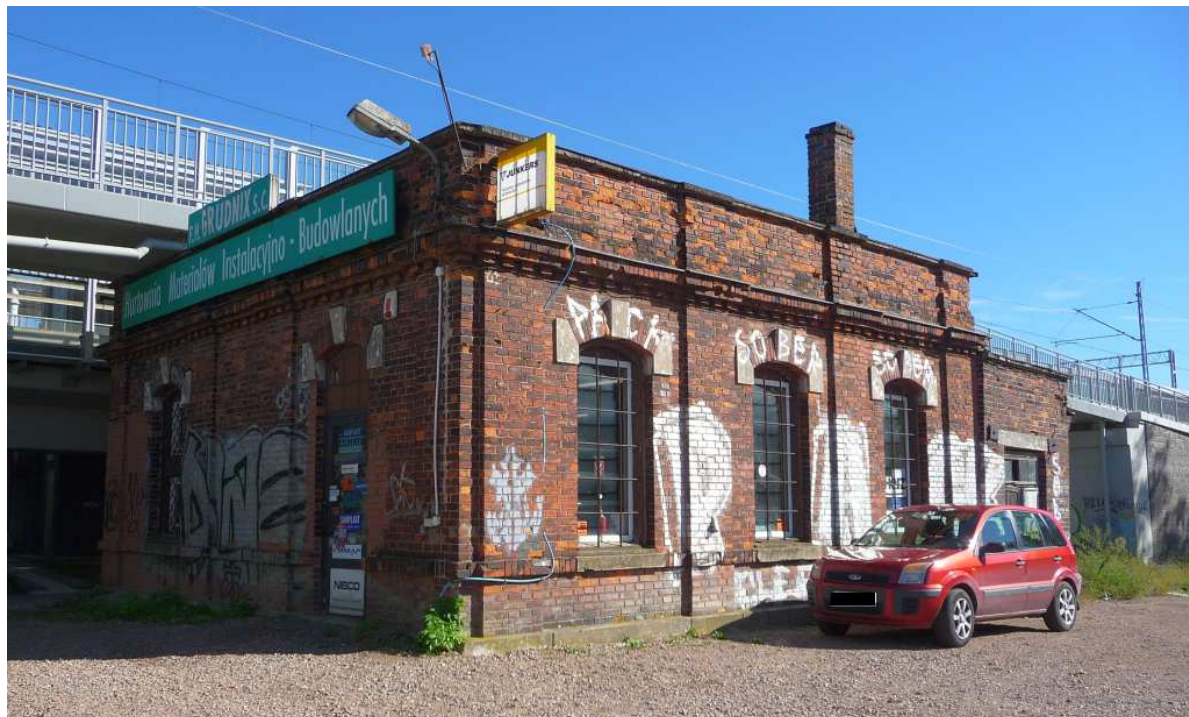
Fot. nr 320 (320-321). Stacja pomp dla parowozowni w Płaszowie przy stacji kolejowej Zabłocie. (10.10.2024)
