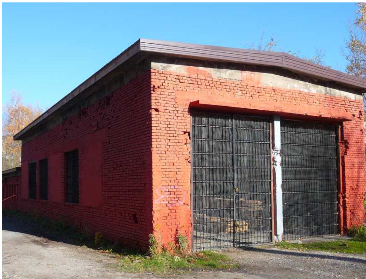
Fot. nr 481. Hala przy zespole krusząco-sortującym skałę wapienną. (06.11.2025)
