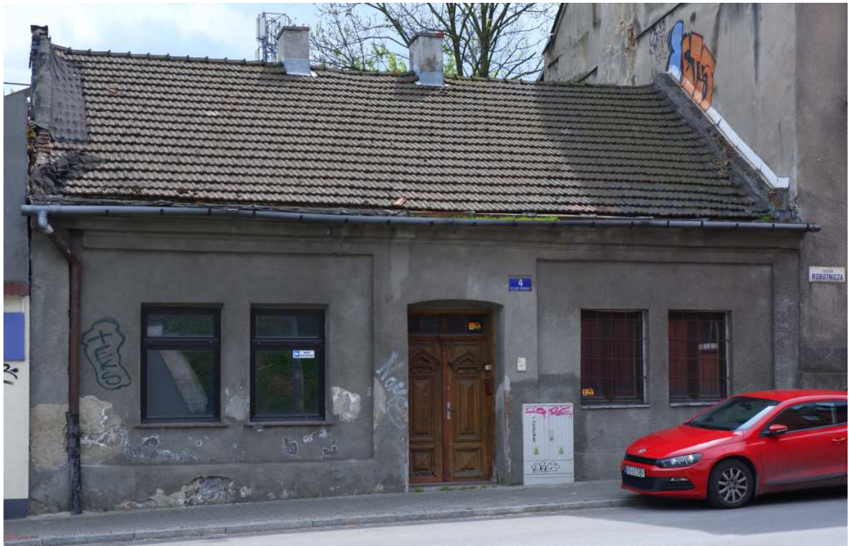
Fot. nr 130 (130-131). Zapewne ponad stuletni dom pod nr 4 i jego detale. (02.05.2023)
