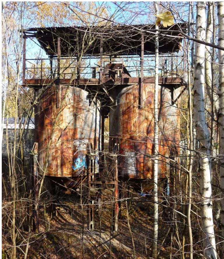
Fot. nr 478 (478-492). We wnętrzu i na obrzeżu kamieniołomu Libana. (06.11.2025) Fot. nr: 478-482. Pozostałości po dawnej infrastrukturze kamieniołomu.
