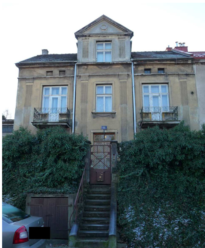
Fot. nr 369 (369-371). Przedwojenna zabudowa ulicy Pod Kopcem. Dom pod nr 22.
