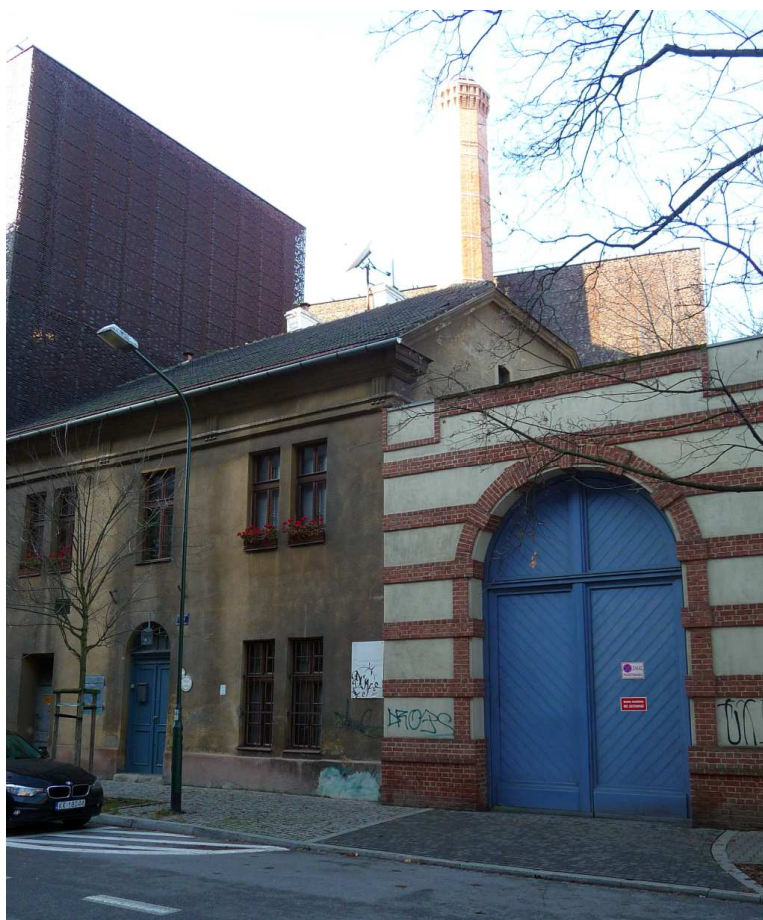
Fot. nr 343. Przebudowany w roku 1926, po zakończeniu działalności elektrowni, na dom noclegowo-kąpielowy dla bezdomnych budynek z ulicy Nadwiślańskiej 4a. (01.12.2024)
