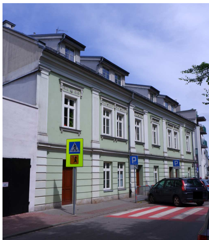
Fot. nr 205 (205-206). Odnowiony dom pod nr 15. (08.05.2024)
