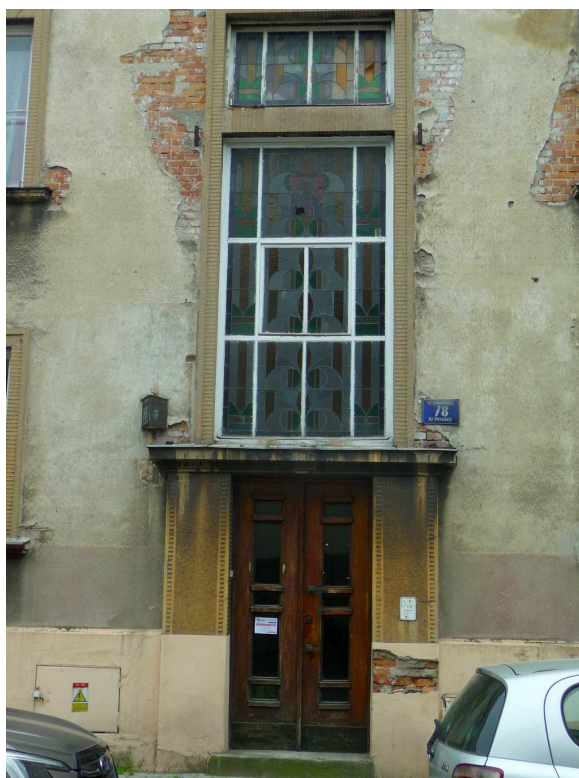
Fot. nr 97. Detale fasady. (25.05.2023)
