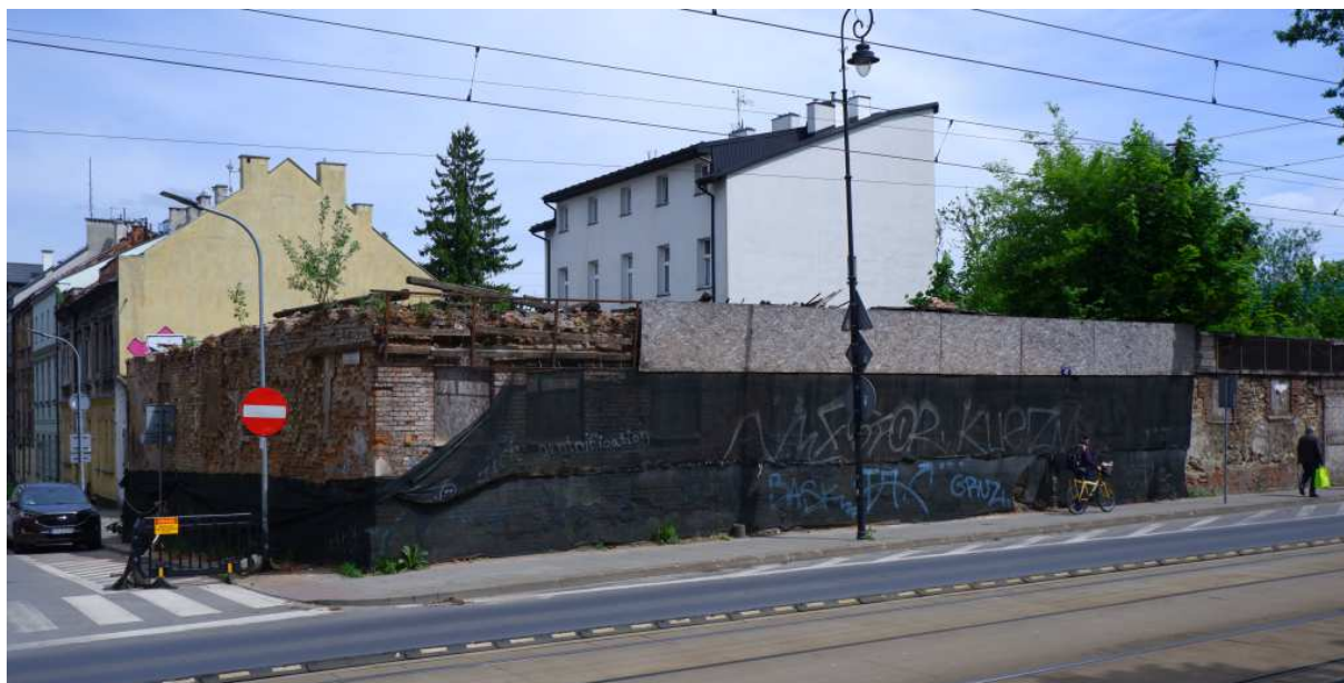
Fot. nr 220. Chyba nic już nie uratuje XVIII-wiecznego domu w kształcie dworku z ulicy Limanowskiego 47. (08.05.2024)
