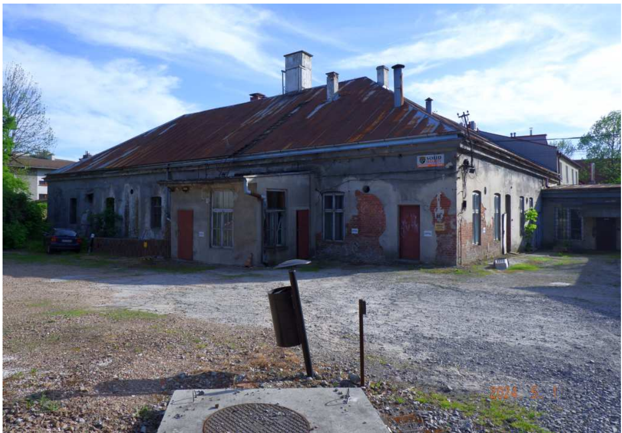
Fot. nr 171. Zabudowania fabryczne, o długiej historii, przy ulicy Dembowskiego 1, które jeszcze trwają.
