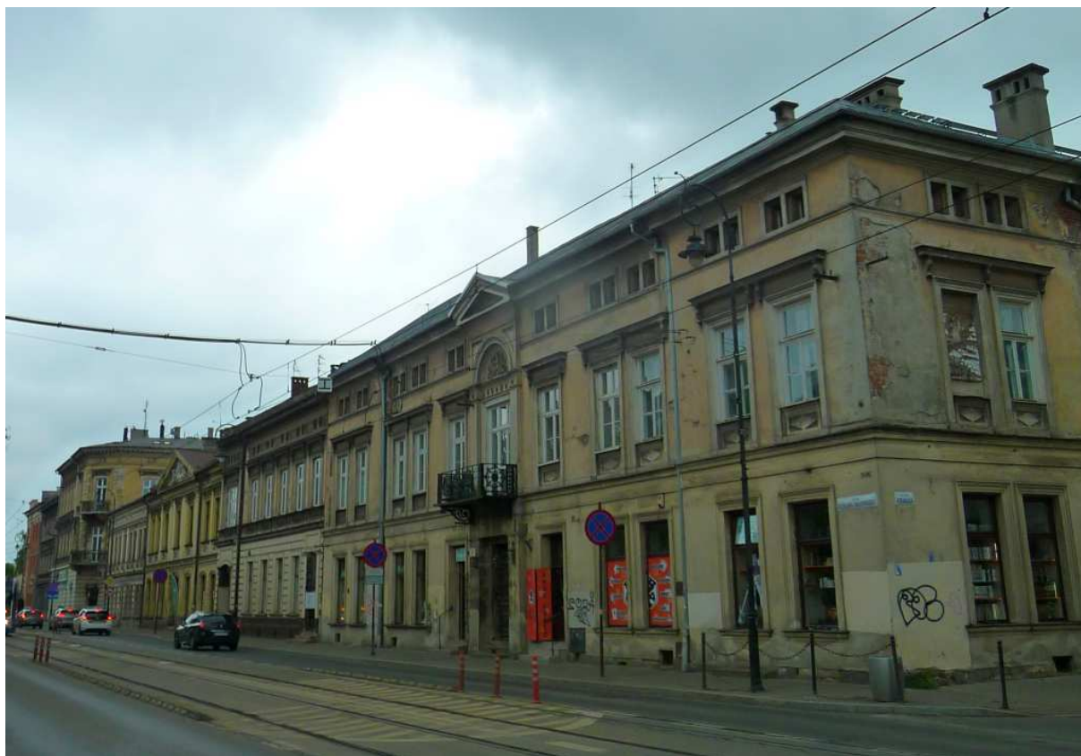
Fot. nr 242 (242-243). Fragment zabudowy o numerach: 16-22 – widok z ulicy Krakusa. (17.04.2024)
