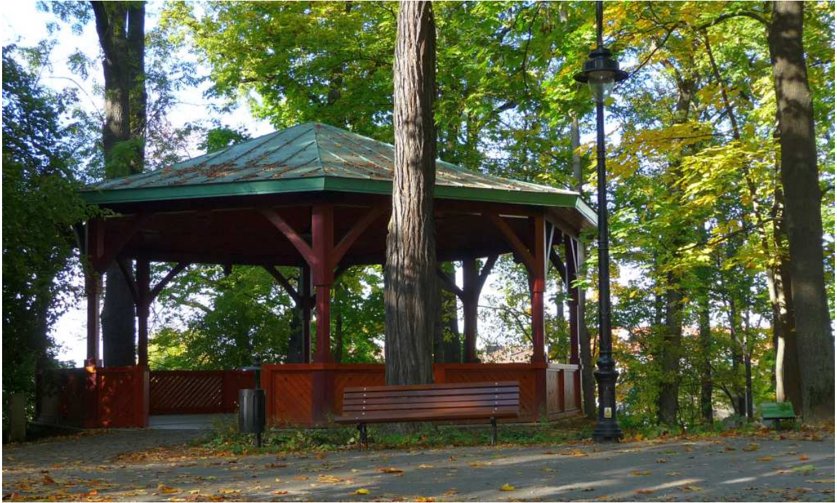
Fot. nr 300. Nowo wybudowana altana. (21.10.2024)
