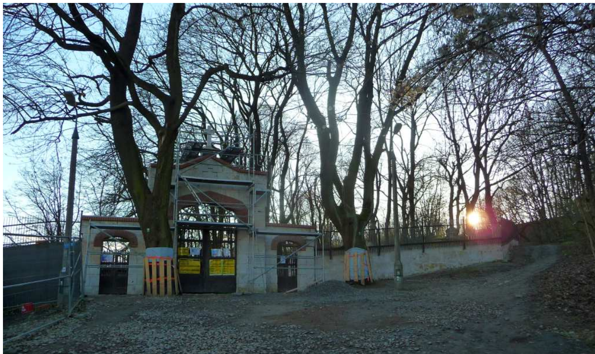
Fot. nr 168. Prace renowacyjne przy bramie wiodącej na stary cmentarz w Podgórzu. (24.03.2024)
