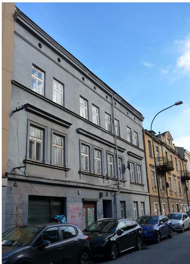
Fot. nr 314. Kamienice pod nr: 16 i 18. (06.10.2024)
