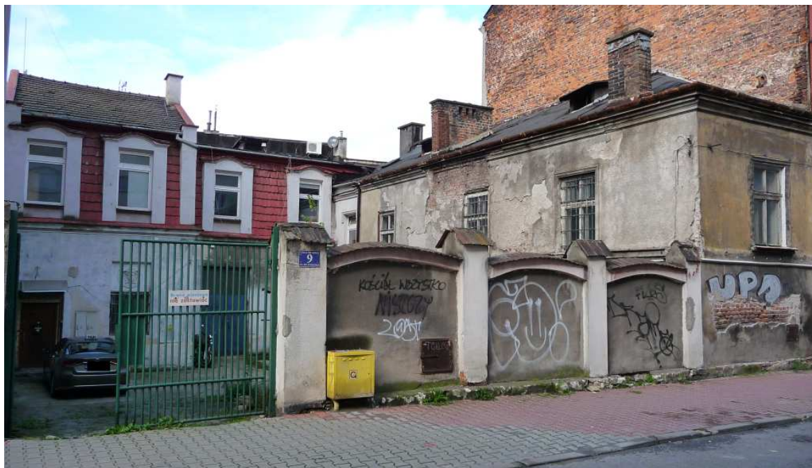
Fot. nr 308. Parterowy dom z początku XX wieku, pod nr 9. (06.10.2024)
