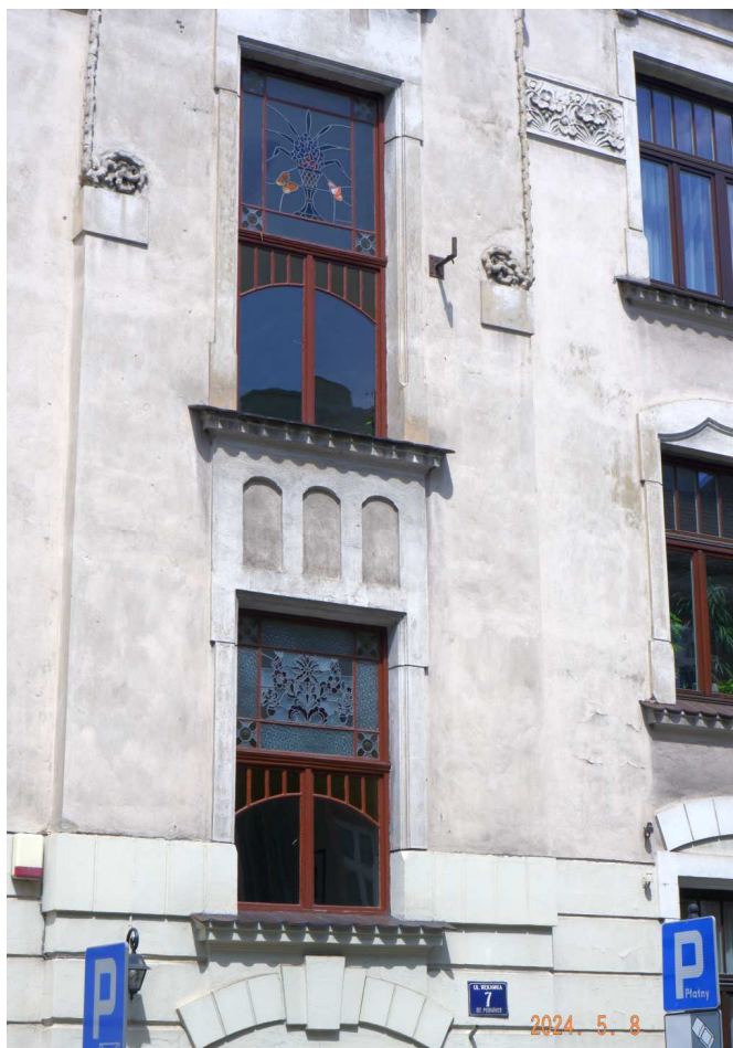
Fot. nr 204. Detale klatki schodowej.
