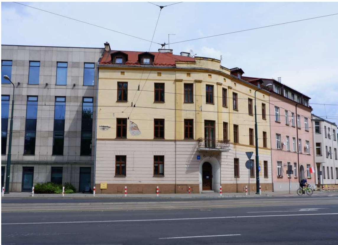
Fot. nr 132. Zabudowa ul. Wielickiej 24-26, której krzywizna przypomina o przebiegającej tędy do czasów okupacji niemieckiej linii kolejowej do Zakopanego. (02.05.2023)
