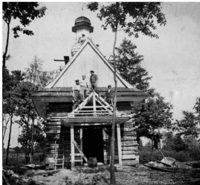
2. Kościół św. Marcina podczas przebudowy w latach 1950-1951. Prace wykonywała ekipa sieprawskich cieśli: Jan Tylek, prowadzący przebudowę, jego brat Tomasz, syn Stanisław, Zygmunt Tylek, Stanisław Pitala i Stanisław Król - z relacji p. Michała Tylka, syna Tomasza.
