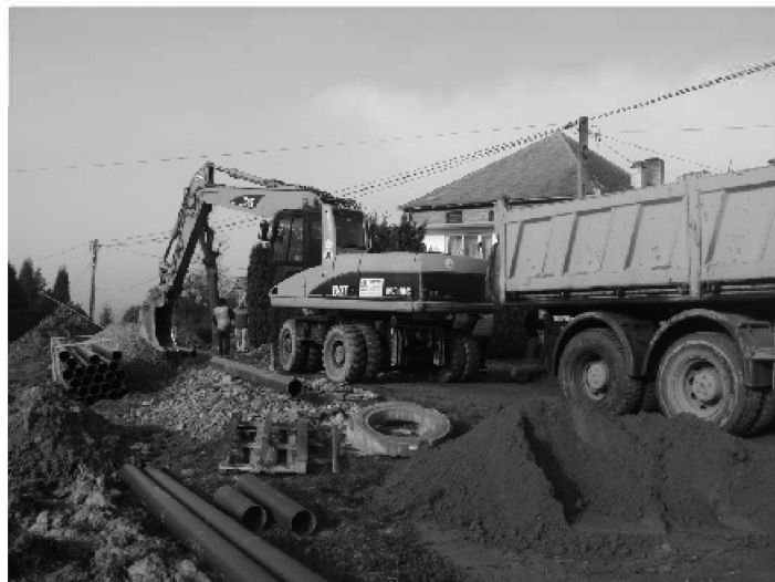
Budowa kanalizacji sanitarnej
