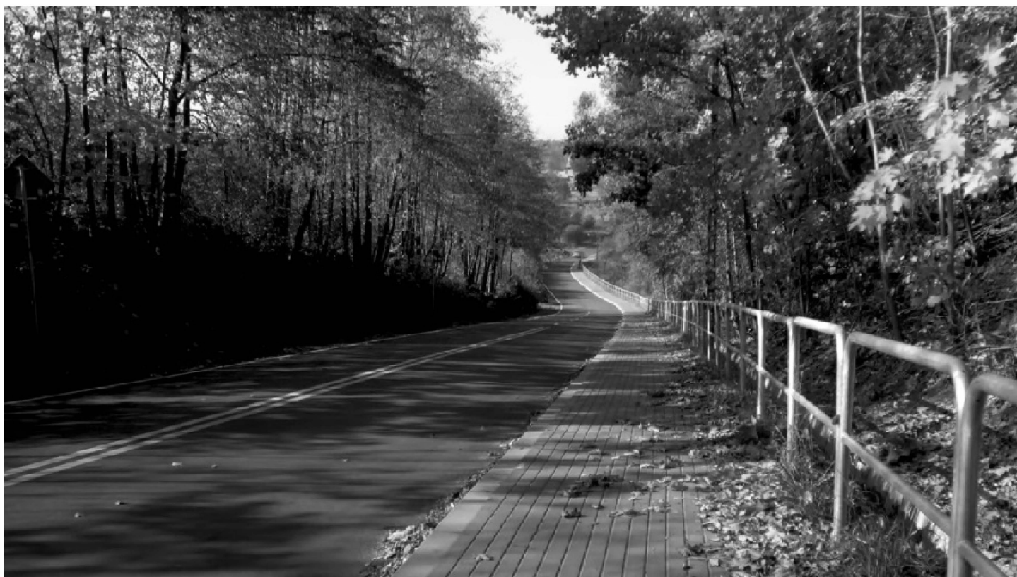
Zmodernizowana ul. Szkolna w Czechówce.
