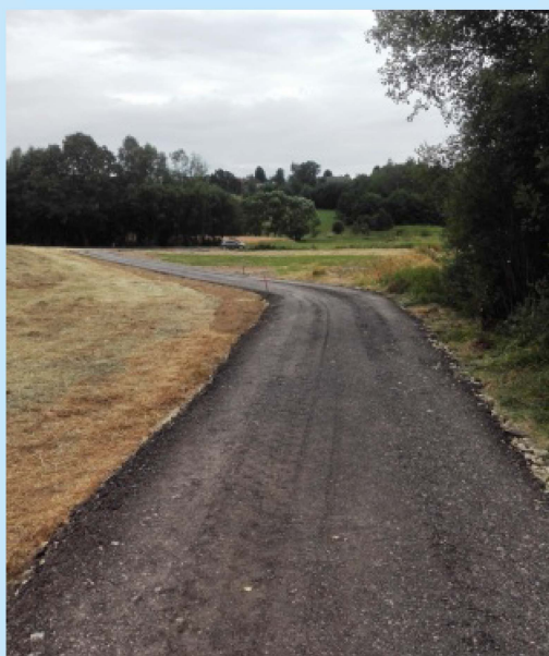
Remont drogi rolniczej, boczna od ul Długiej (323m) w Sieprawiu str. 6
