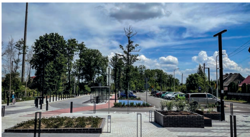
Park and Ride w Podłężu w trakcie budowy i po.
