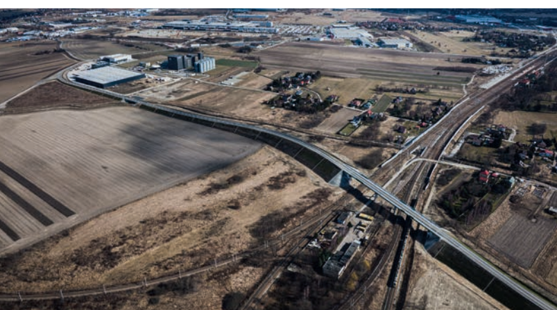
Obwodnica Podłęża w trakcie budowy i po.
