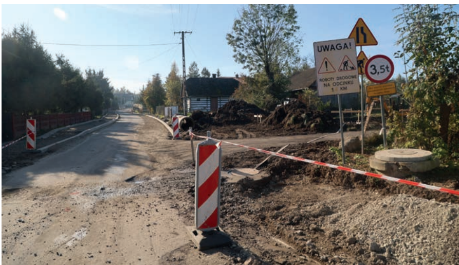
Trwa przebudowa drogi prowadzącej od centrum Słomirodu do drogi krajowej 94 (odcinek ok. 850 m)
