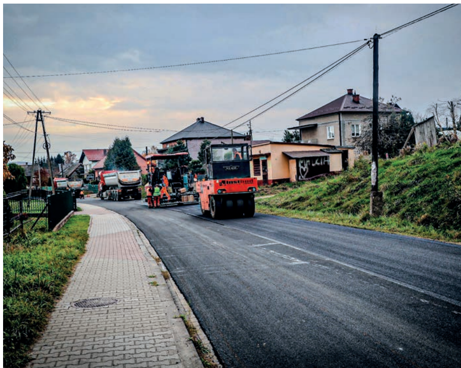
Dobiegają końca prace remontowe na drodze powiatowej 2014K w Zakrzowie
