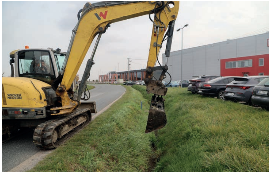
Prace melioracyjne przeprowadzono łącznie na odcinku 15 km
