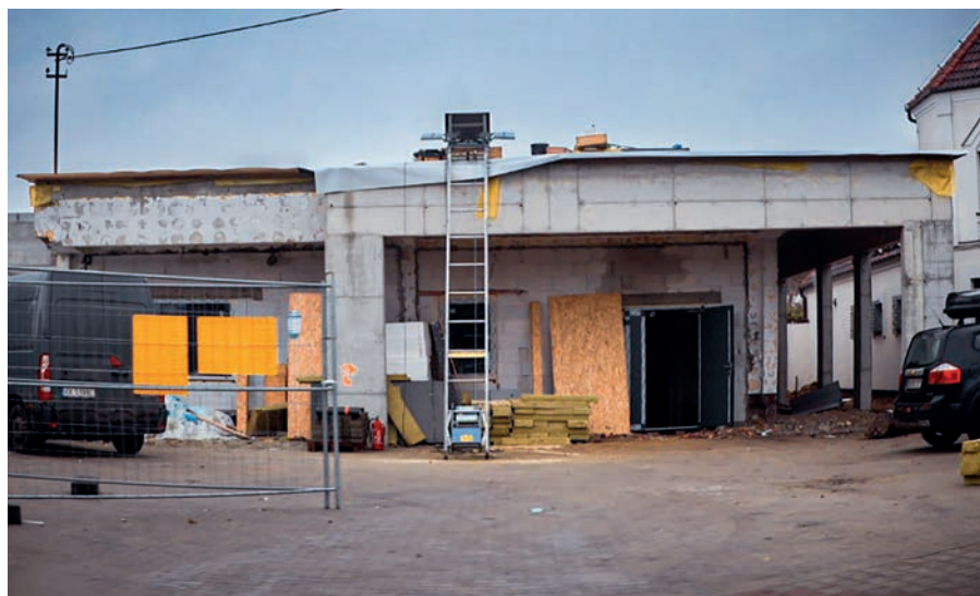
Trwają prace przy budowie klubów malucha Jaś i Małgosia
