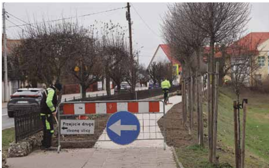
Trwają prace na 120-metrowym odcinku chodnika przy ul. 3 Maja, od parku miejskiego do Zespołu Szkół
