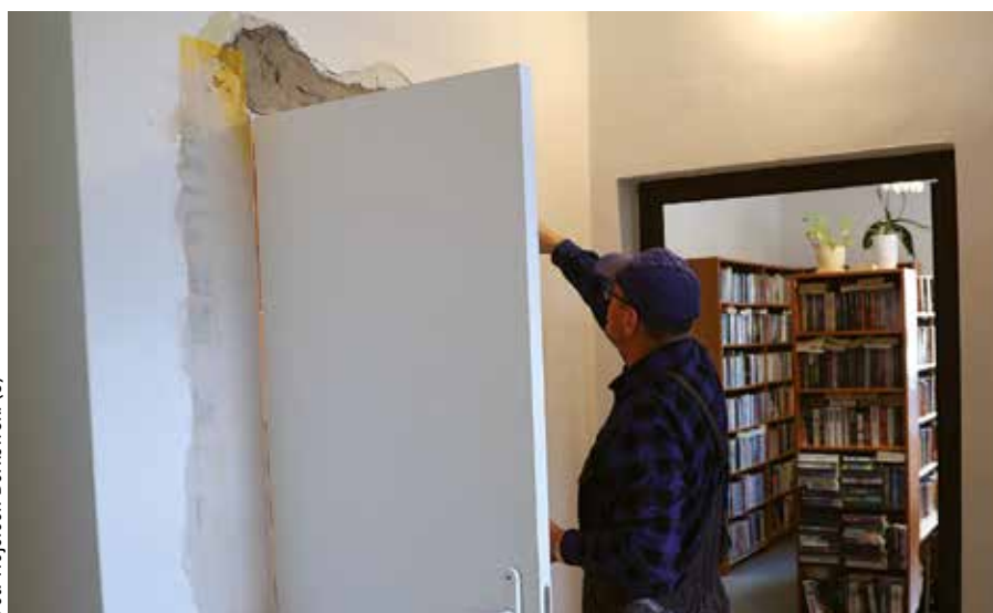
W styczniu przeprowadzono remont pomieszczeń filii Biblioteki Publicznej w Staniątkach
