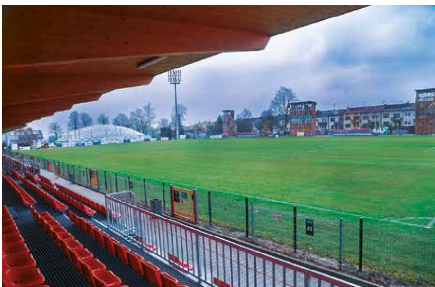
Zakończono remont trybun i budowę wież telewizyjnych na stadionie miejskim.
