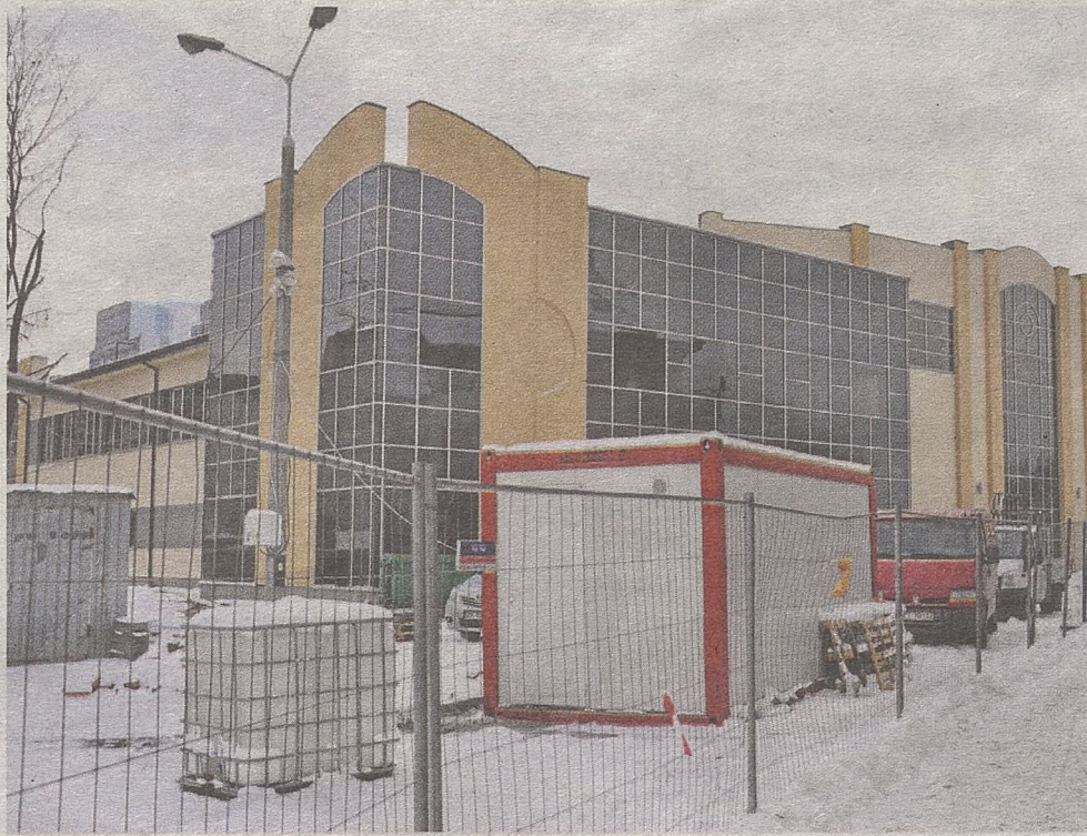
Wiosną zaplanowano oddanie hali widowiskowo-sportowej. To będzie pierwszy tego typu obiekt w Bochni
