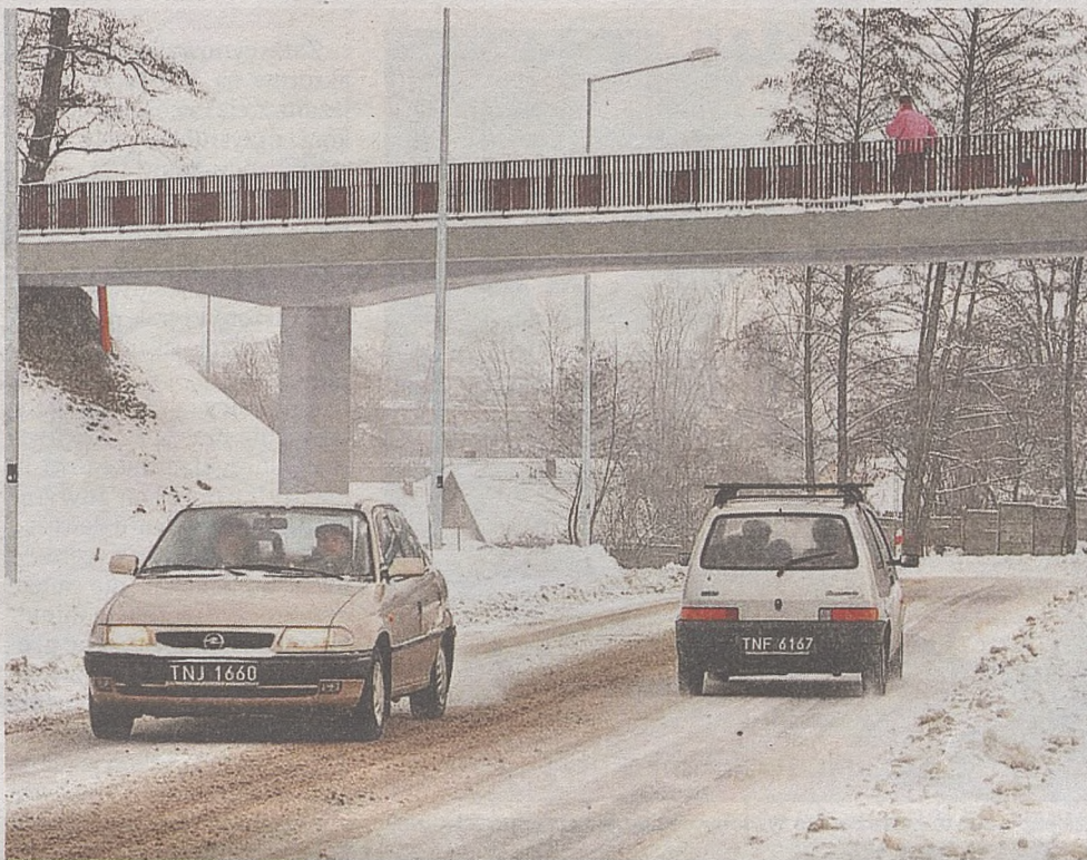
Na razie ruch na trasie KN-2 jest niewielki. Z pewnością potrzeba czasu, aby oswoić się z nową drogą
