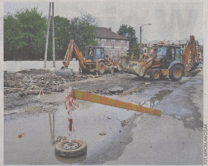
Prace budowlane trwają od kilku dni
