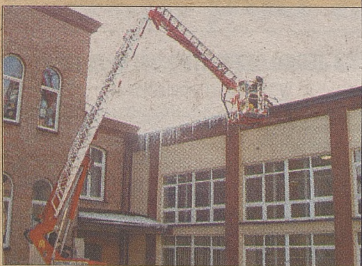
Strażacy czyszczą dach bocheńskiej „jedynki”
