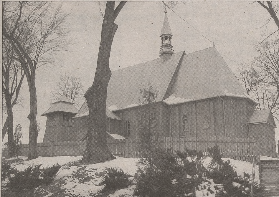
Kościół i dzwonnica z zewnątrz już odnowiono. Dopełnienie dzieła wymaga jeszcze zmiany pokrycia dachu – z blachy na gont
