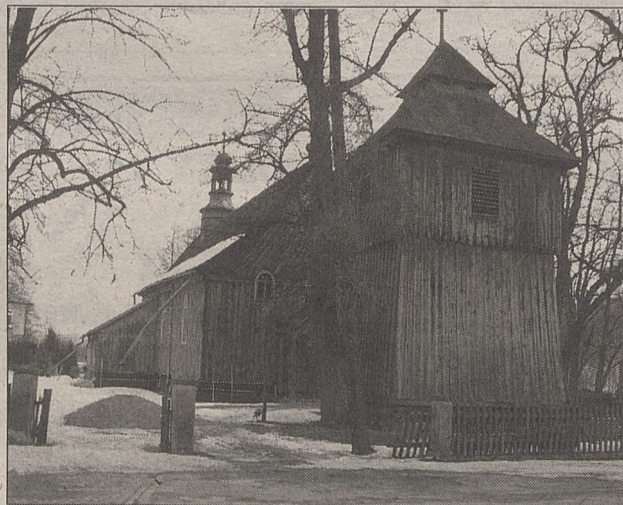
Zabytkowemu kościółkowi w Łapanowie nie grozi już zamknięcie
