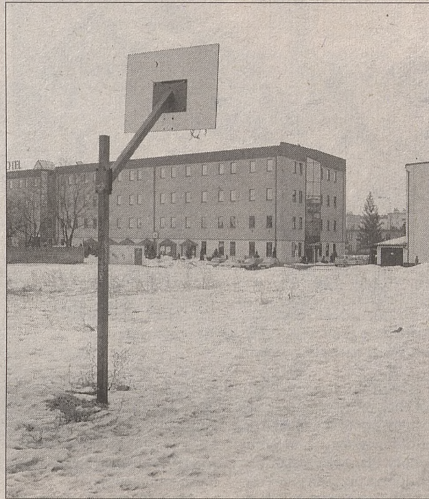
Miejsce pod halą widowiskowo-sportową jest już gotowe
