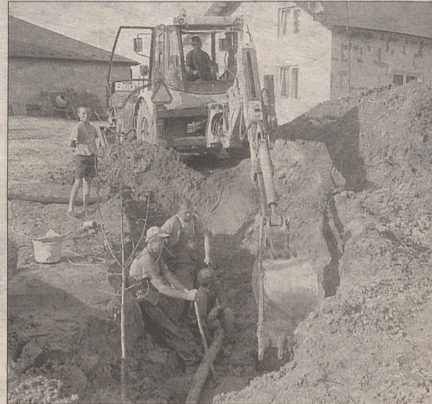
Kończy się budowa sieci kanalizacyjnej przy ulicy Topolowej. Właściciele posesji znajdujących się przy Brzeskiej muszą nadal czekać
