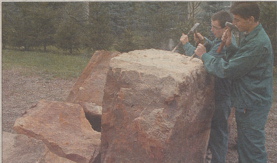
W Łapanowie przygotowują olbrzymi głaz z pobliskiego kamieniołomu. 17 października przy Zespole Szkół im. Jana Pawła II w Łapanowie zaplanowano odsłonięcie obelisku z zegarem słonecznym. – Podobnym jak w Wadowicach. Będzie przypominał nam o Ojcu Świętym – wyjaśnia dyrektor ZS, Jan Wójcik. Na obelisku będzie też tablica ze słowami: „Czas ucieka, wieczność czeka” i „Temu, który odkrył oblicze ziemi Janowi Pawłowi II – spofeczność szkolna” FOT. MAŁGORZATA WIĘCEK
