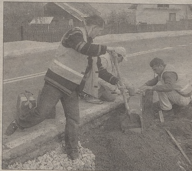
Budowa zatok zdecydowanie poprawi bezpieczeństwo na drodze wojewódzkiej 965
