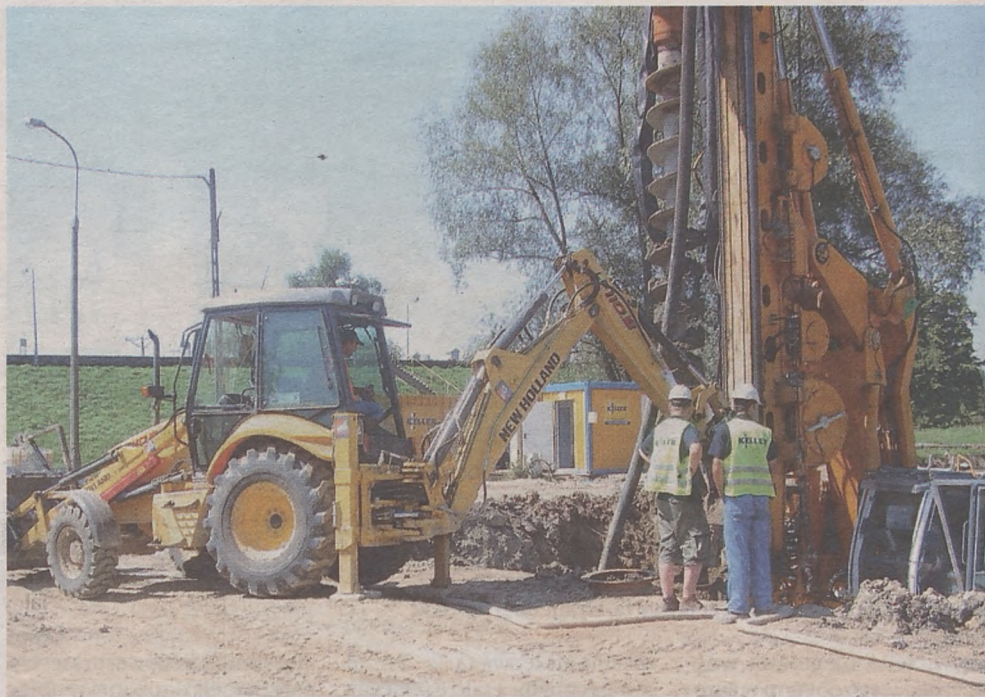
Latem ruszyły prace przy modernizacji zakładu uzdatnia wody – to olbrzymia inwestycja
