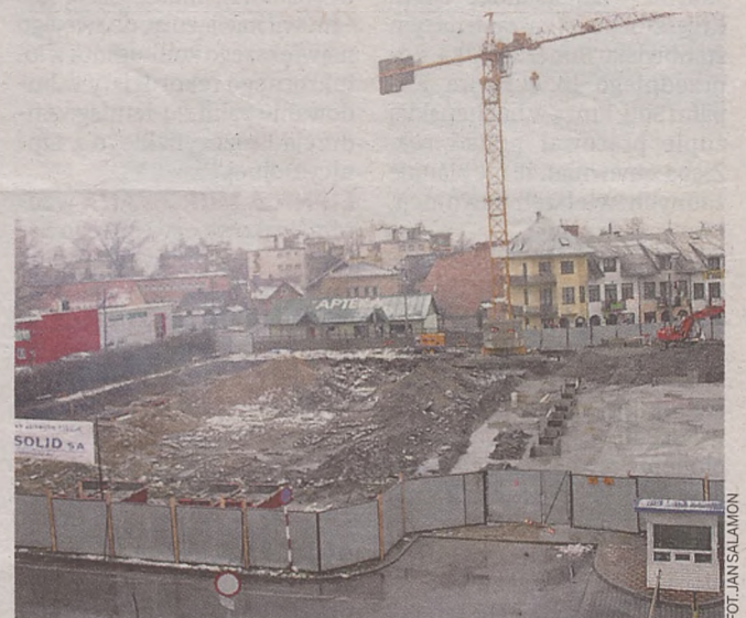
Wykopy pod fundamenty na placu budowy nowej bocheńskiej hali sportowo-widowiskowej
