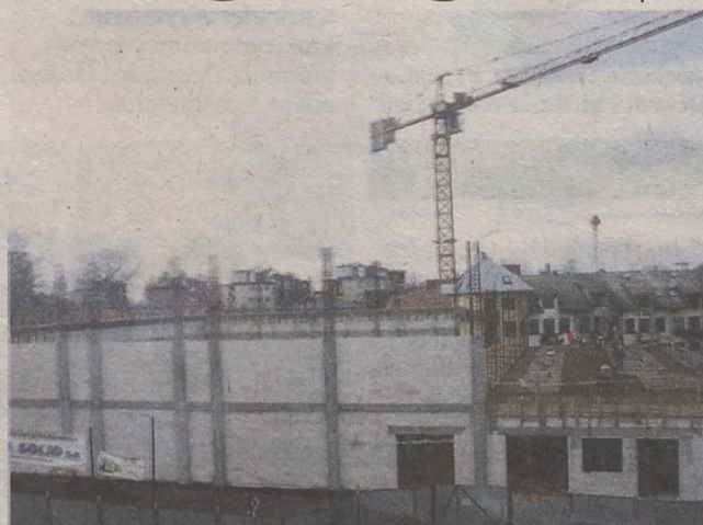
Na zdjęciu z prawej strony widać obecny stan prac przy budowie stropu nad zapleczem hali
