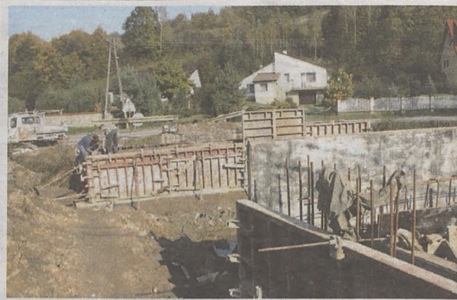
Tak wygląda obecnie fragment budowy mostu w Królówce
