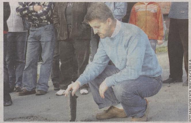
Tymczasowe łatanie nic nie daje, asfalt odpada po kilkunastu dniach
