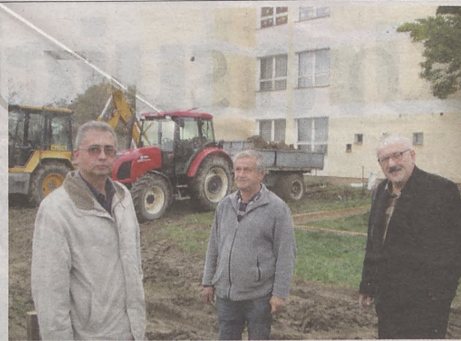
Robert Gabryel, Jan Fąfara i Jerzy Lysy przy rozbudowie szkoły
