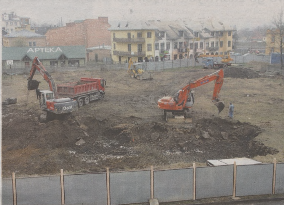
Właśnie ruszyła budowa hali widowiskowo-sportowej, jednej z dwóch największych inwestycji Bochni
