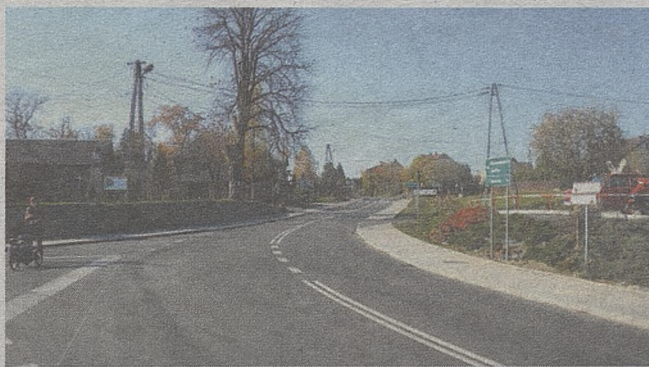
Budowa chodników oraz remont skrzyżowania drogi powiatowej w Zawadzie i Nieszkowicach Wielkich
