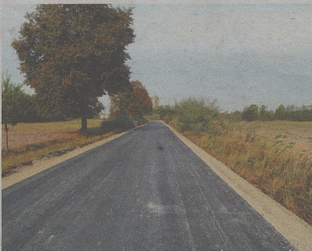
Remont drogi powodziowej
