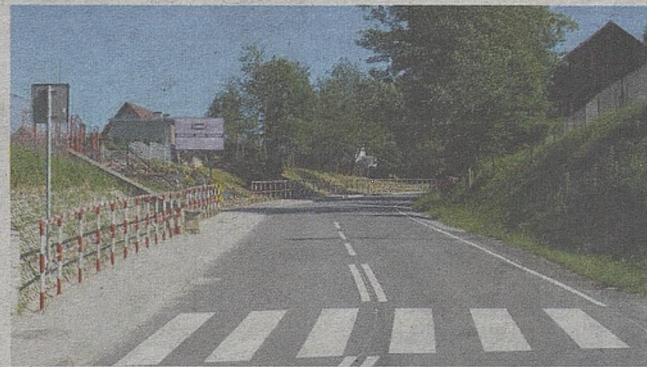
Budowa tzw. ciągu południowego. Na zdjęciu wyremontowana droga w Trzcianie
