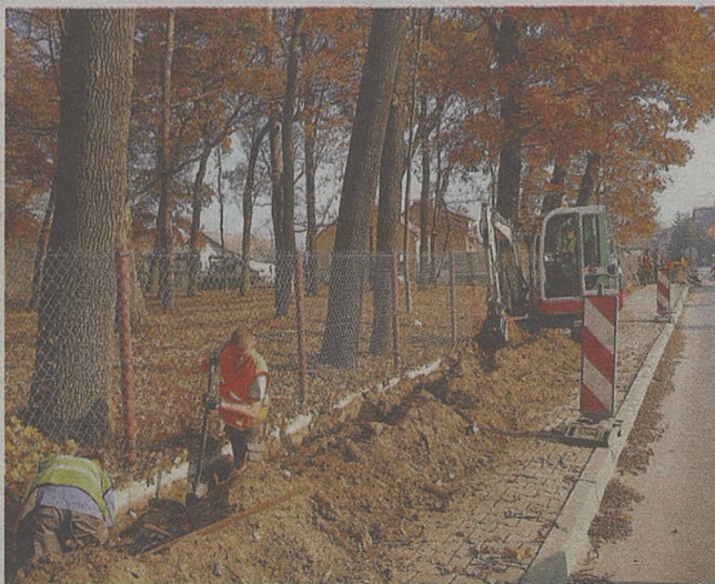
Budowa linii światłowodowych
