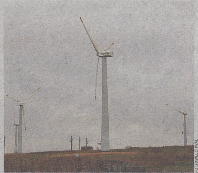
Na farmie pod Przyborowem stanie 17 wiatraków o wysokości 120 m
