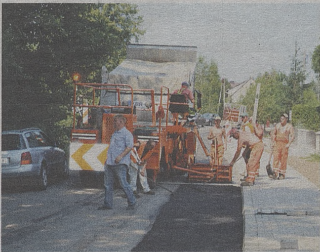
Na terenie całego powiatu bocheńskiego trwają remonty dróg
