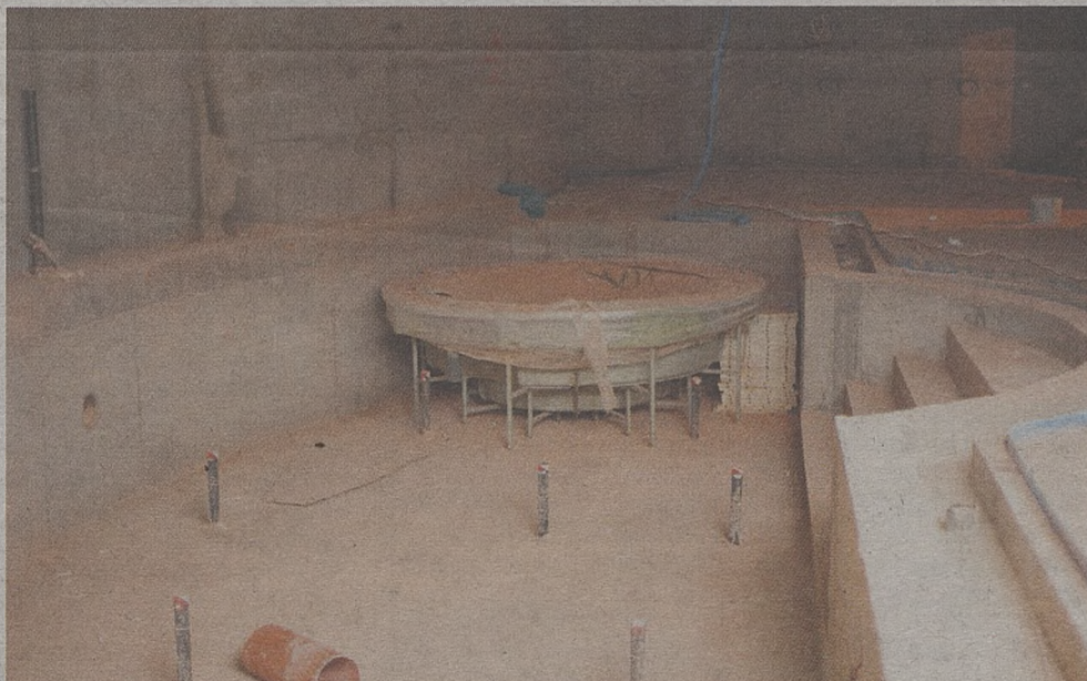
Spa w piwnicach to na razie wielki plac budowy. Na zdjęciu: niecka basenu, w którym będą kąpiele piwne
