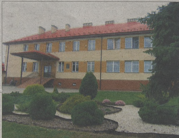
Zespół przedszkolno - szkolny w Dębnie po wykonaniu elewacji
