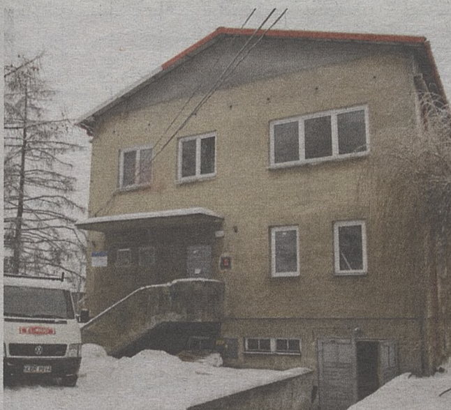
Budynek zostanie wyremontowany za kwotę ponad 100 tys. złotych
