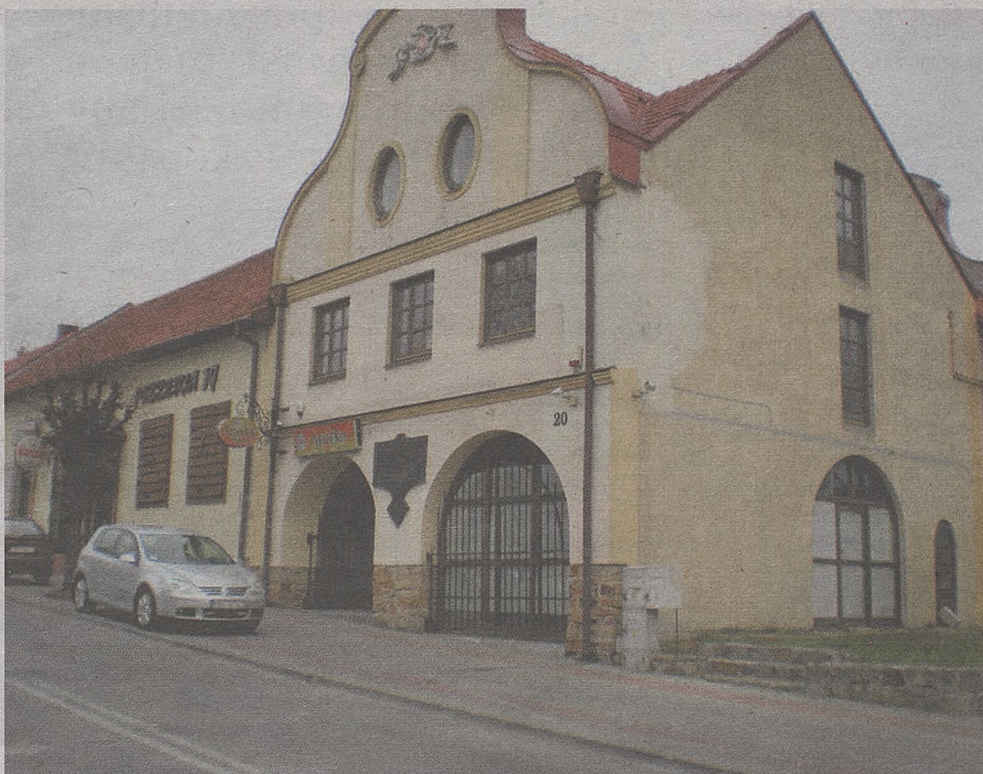
▶ To w tej kamienicy miało dojść do rzekomych podtopień, dziś budynek mają nowego właściciela
