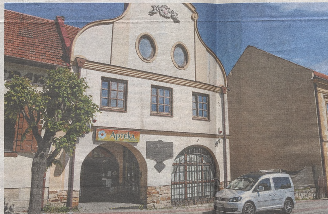
► W tej kamienicy przy wiśnickim Rynku w czerwcu 2010 roku miało dojść do zalania kilku pomieszczeń, na których remont Michał G. zdaniem prokuratury wyłudził 50 tys. zł z MARR w Krakowie
