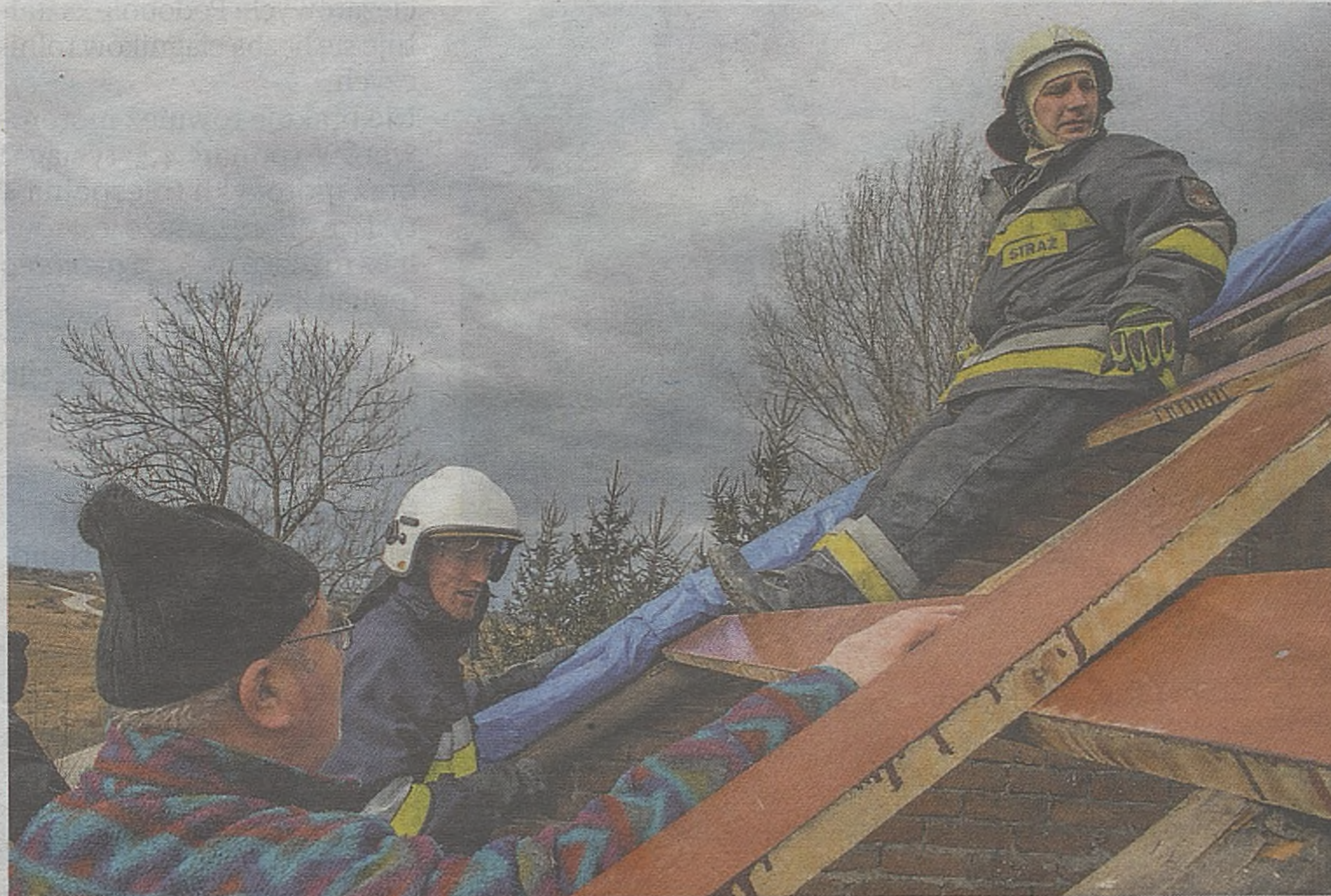
► Jan Nosal z Woli Drwińskiej razem ze strażakami zabezpieczał więźbę dachową specjalną folią. Dobrze, że gospodarz miał deski, którymi przybito prowizoryczne pokrycie. Przed nim wiele pracy
