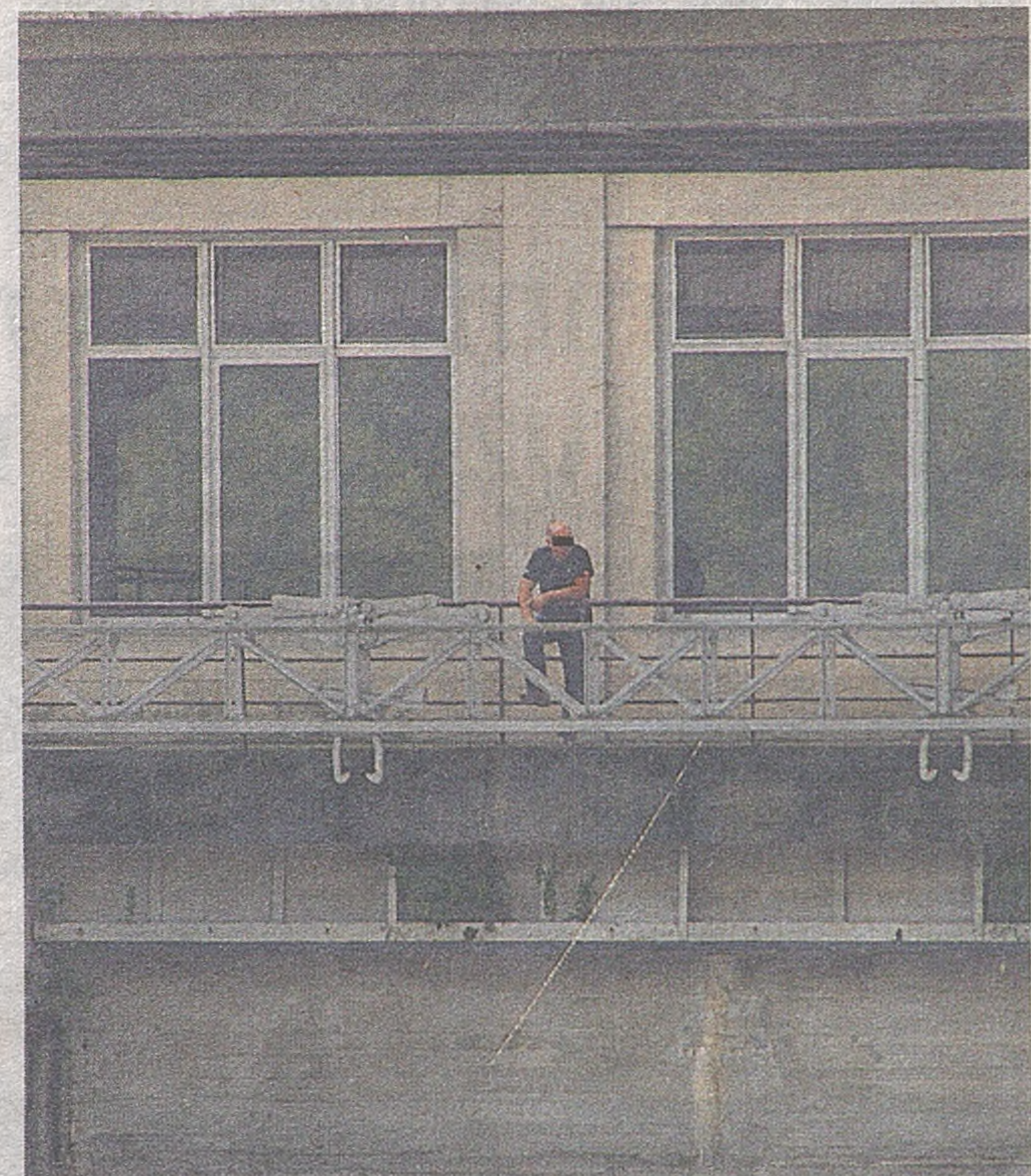
Na zaporze wodnej w Czchowie obowiązuje zakaz łowienia ryb. Niektórzy pracownicy elektrowni nic sobie z tego nie robili
