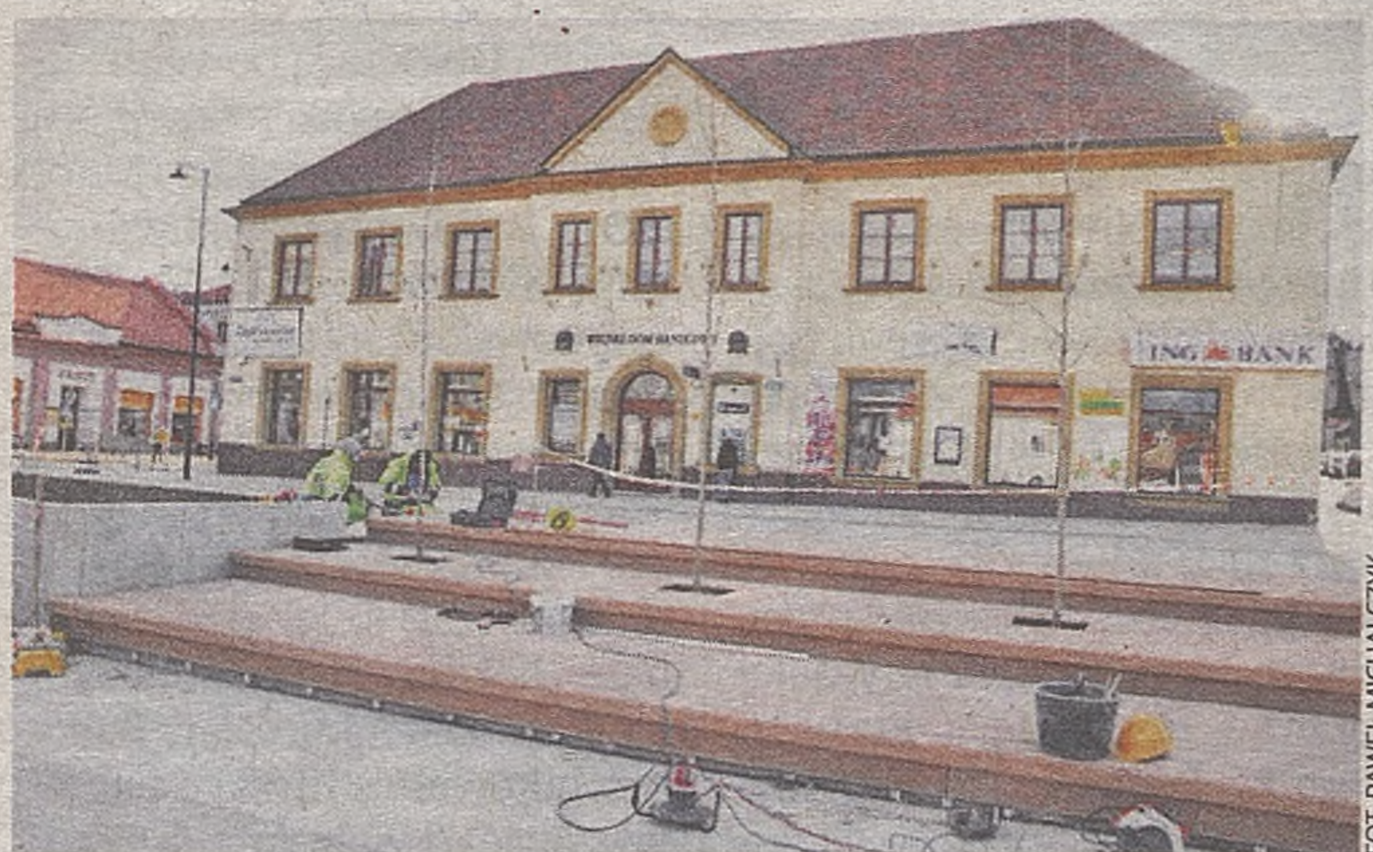
Nowym elementem są tarasy, na których będzie można usiąść. Z pewnością sprawdzą się one w ciepłe dni
