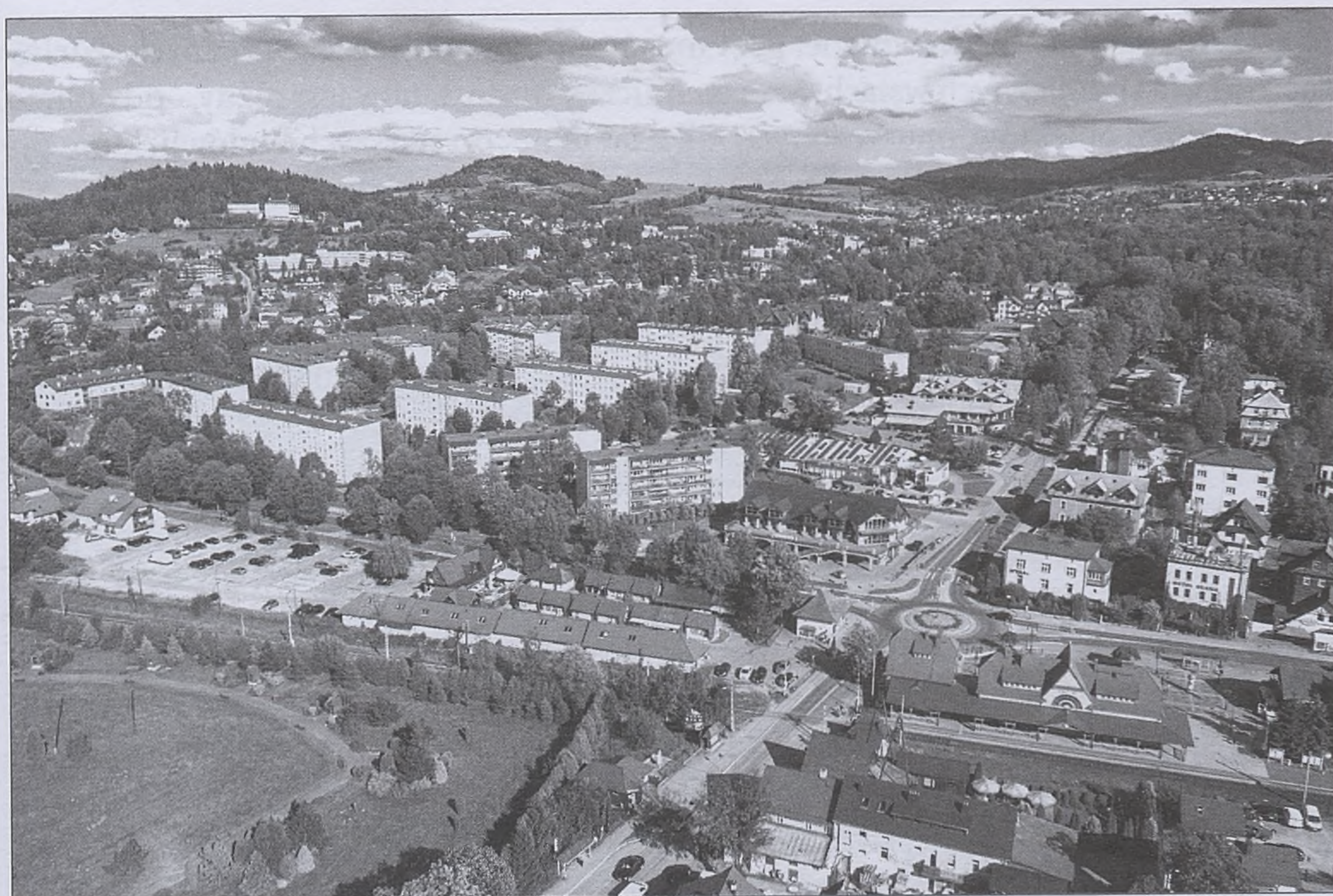
Osiedle bloków mieszkalnych przy ulicy Orkana, 2021 r. Fot. P. Kuczaj
