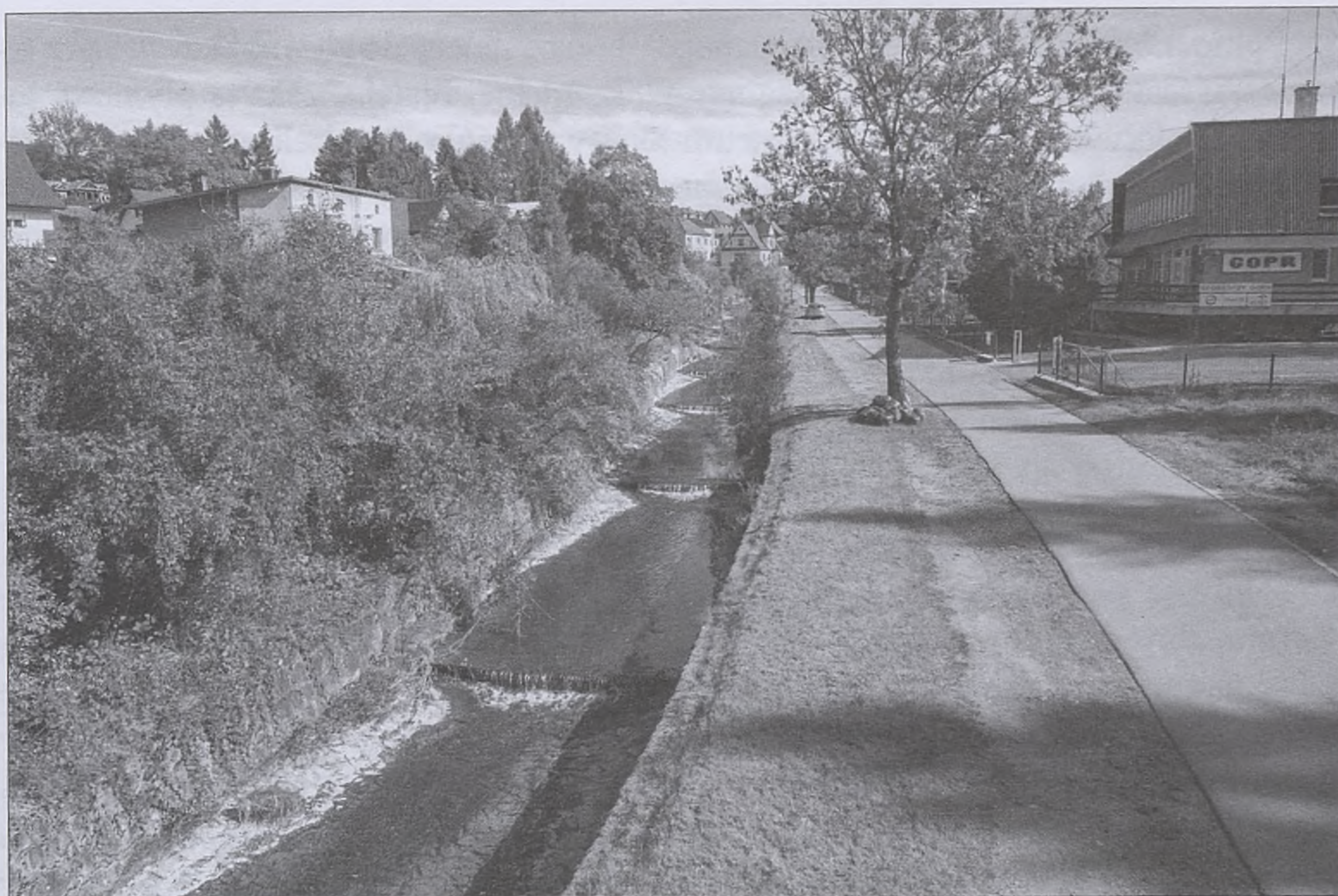
Potok Słonka z zabudowanym korytem wzdłuż al. Tysiąclecia, 2021 r. Fot. P. Kuczaj
