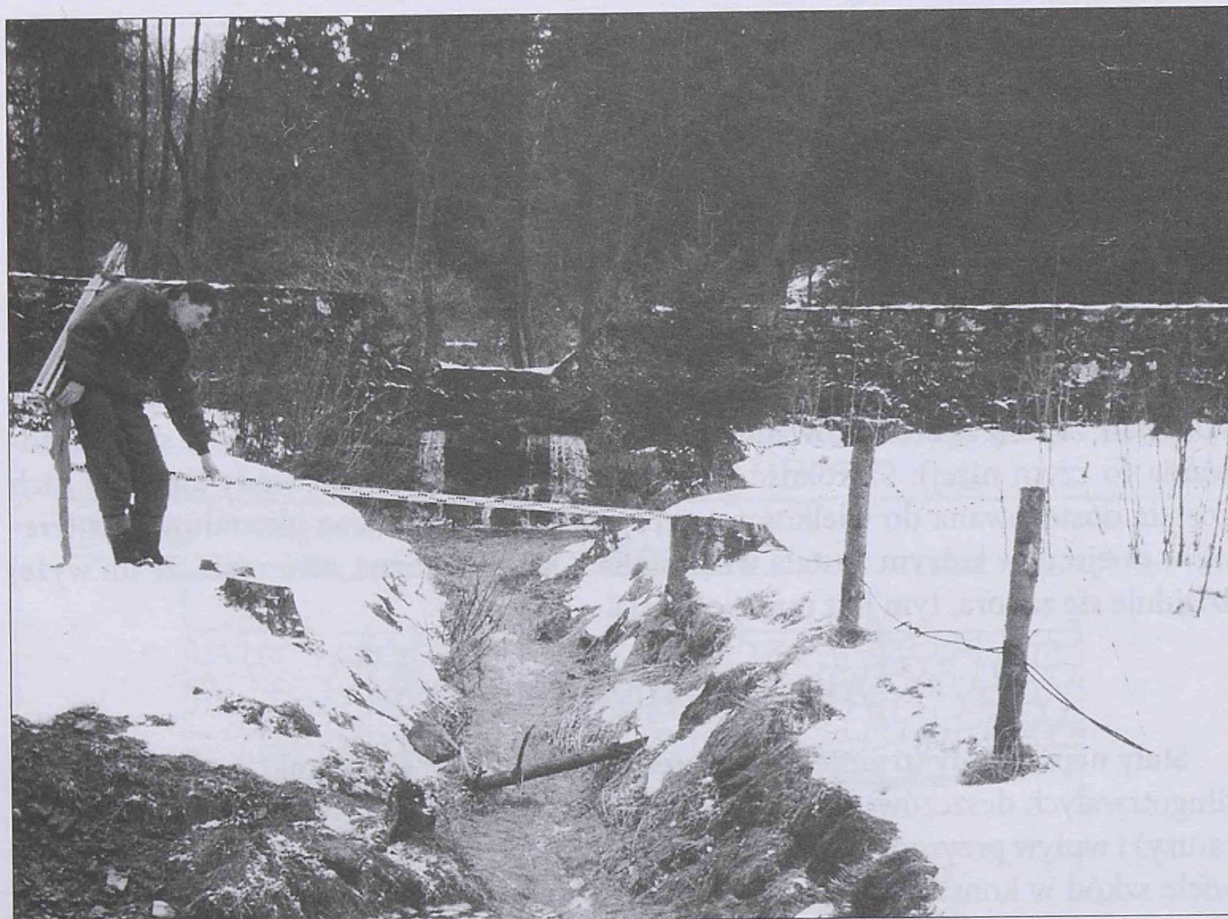
Najniższa zaporę na potoku Gorzki, stan z lat 90. XX w. Dokumentacja inwentaryzacyjna, zbiory Regionalnego Zarządu Gospodarki Wodnej w Krakowie Zarząd Zlewni Raby
